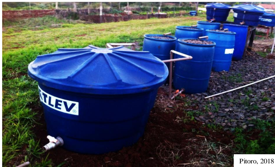
Figura 9 – ETAR instalado no Campus da FCA-Unesp, Botucatu (FASE I)
