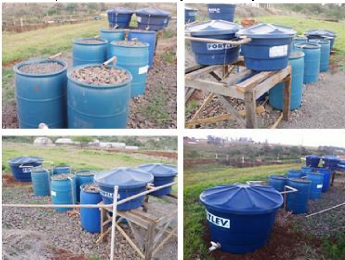
Figura 2. Ilustração da ETAR instalado no Campus da FCA-Unesp, Botucatu
