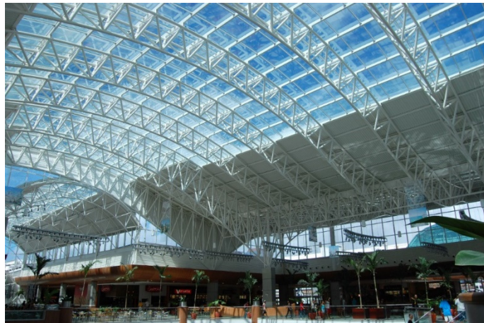
Figura 2 - Cobertura de estrutura tubular em um shopping de Salvador
