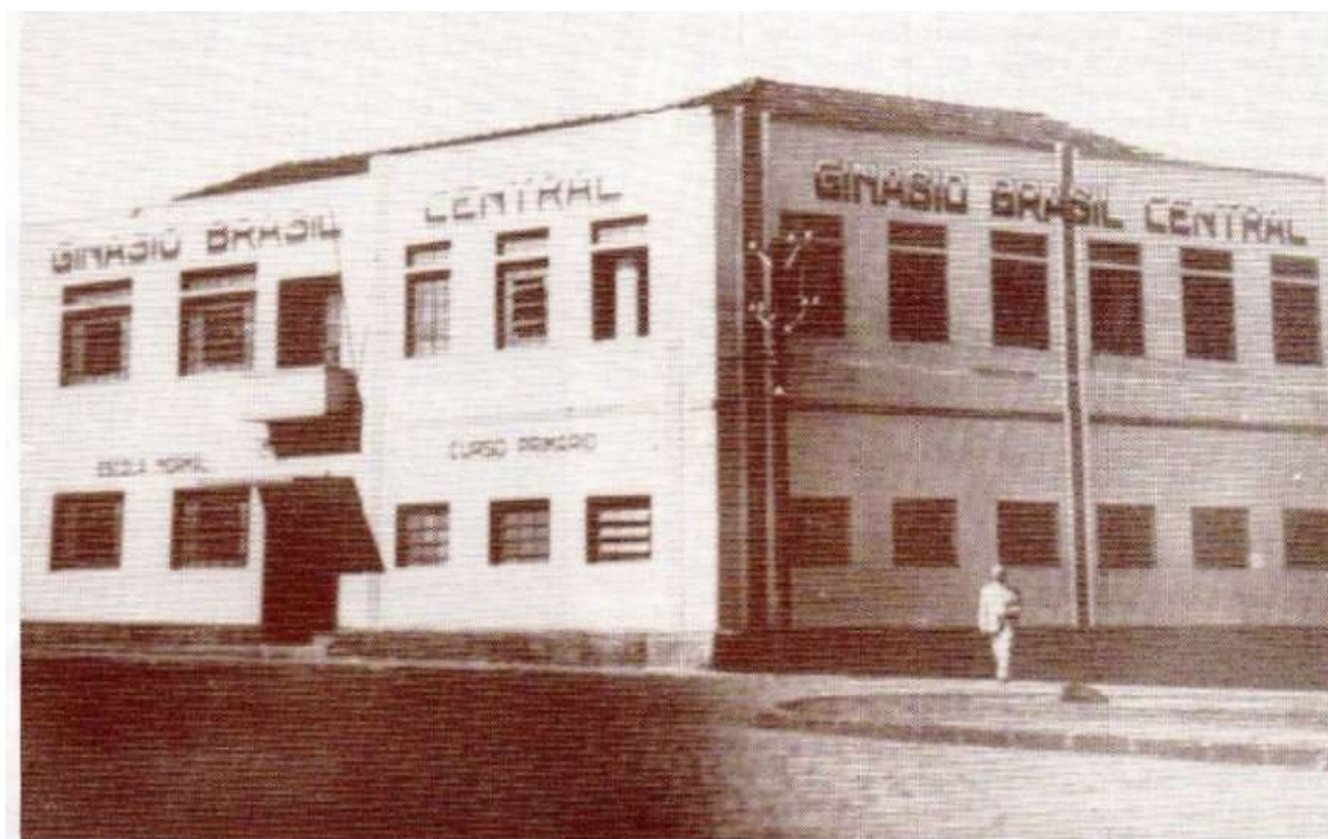
Figura 22 – Fachada do prédio do Ginásio Brasil Central
