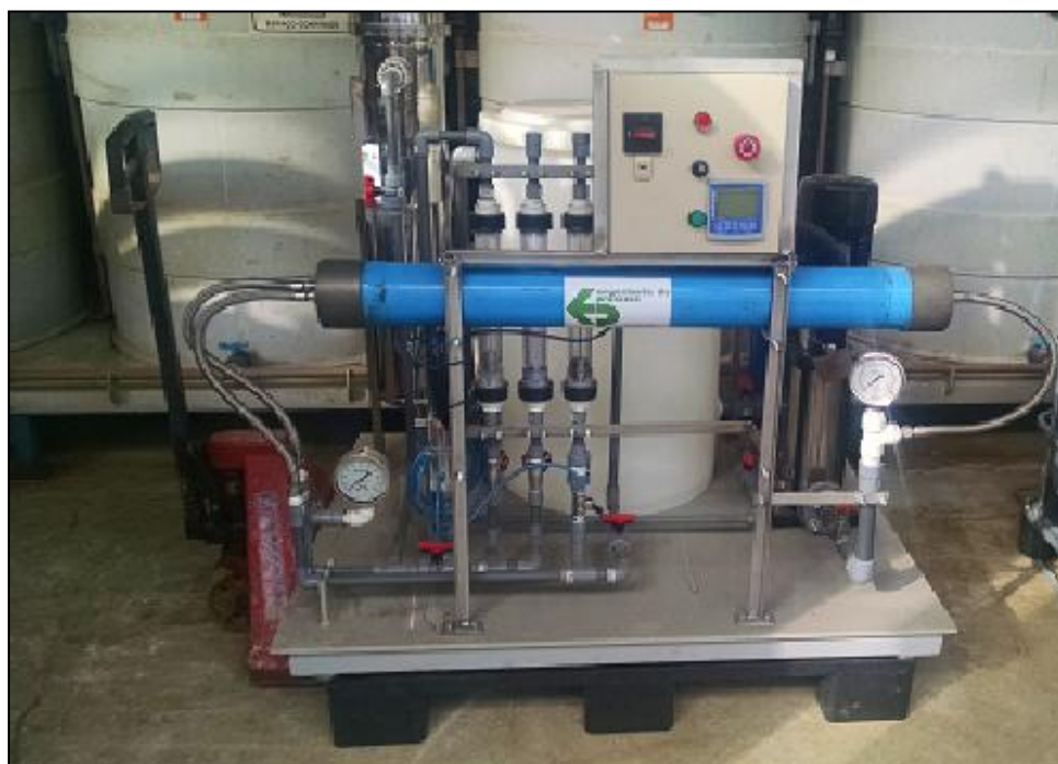
Figura 14 – Unidade de osmose reversa ( skid ) utilizado no ensaio-piloto.
