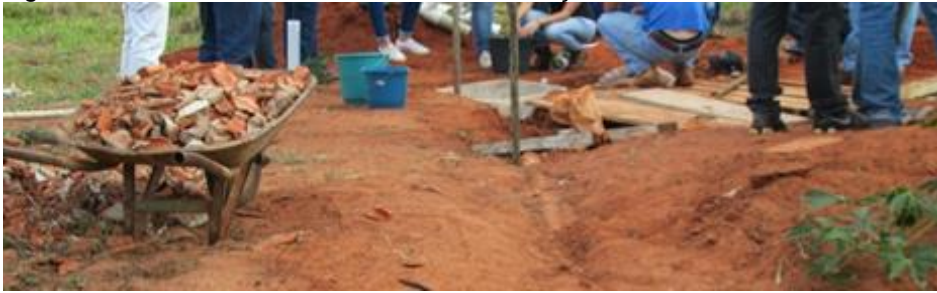
Figura A.3 – Entulho utilizado na vala de infiltração
