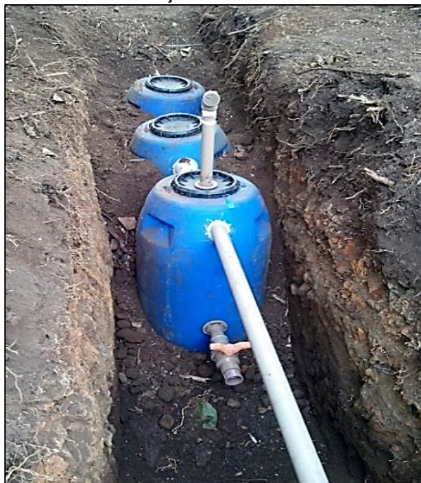
Figura 1.3 – Fossa Séptica Econômica (FSE) após instalação em Botucatu/SP.
