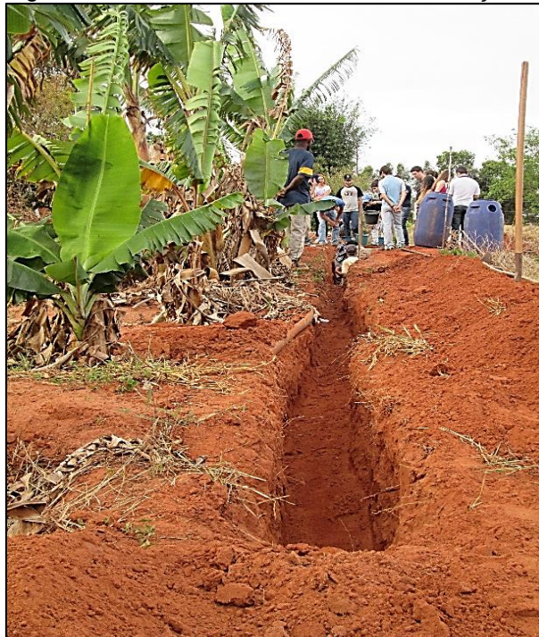
Figura A.4 – Área do fundo da vala de infiltração.
