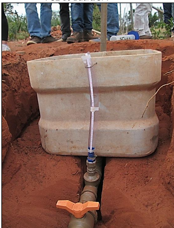
Figura 1.5 – Caixa para medição de vazão e coleta de amostras do esgoto afluente da FSE de Bauru/SP.
