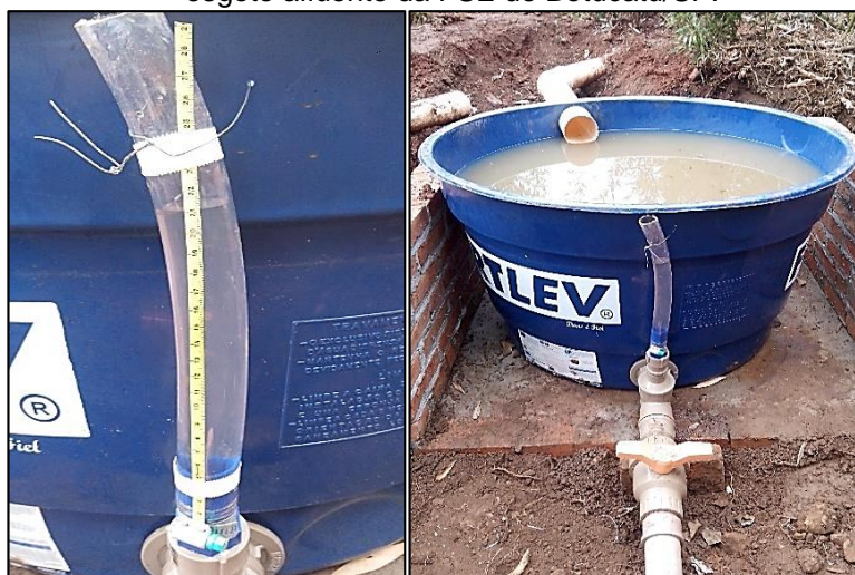
Figura 1.4 – Caixa de medição da vazão e coleta de amostras do esgoto afluyente da FSE de Botucatu/SP.
