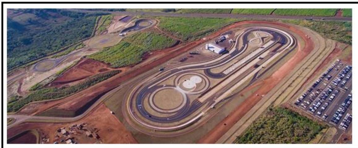
Figura 41: Pista de testes de ônibus e caminhões pronta.
