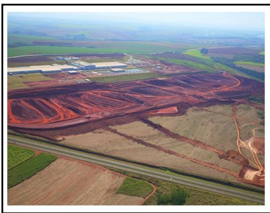
Figura 40: Pista de testes de ônibus e caminhões em construção
