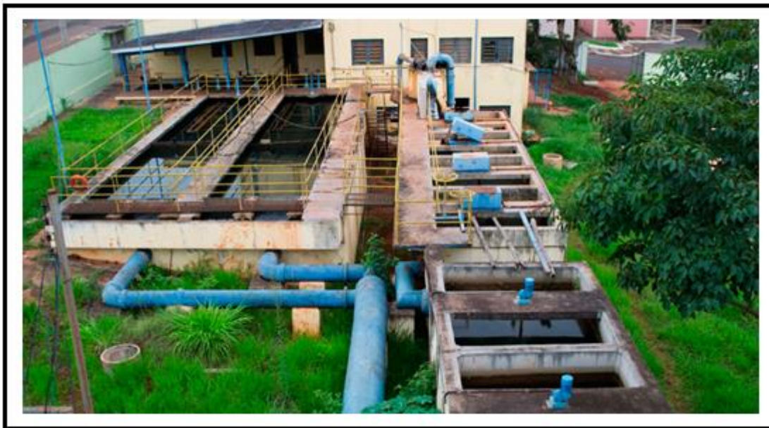
Figura 35: Estação de tratamento de água de Iracemápolis
