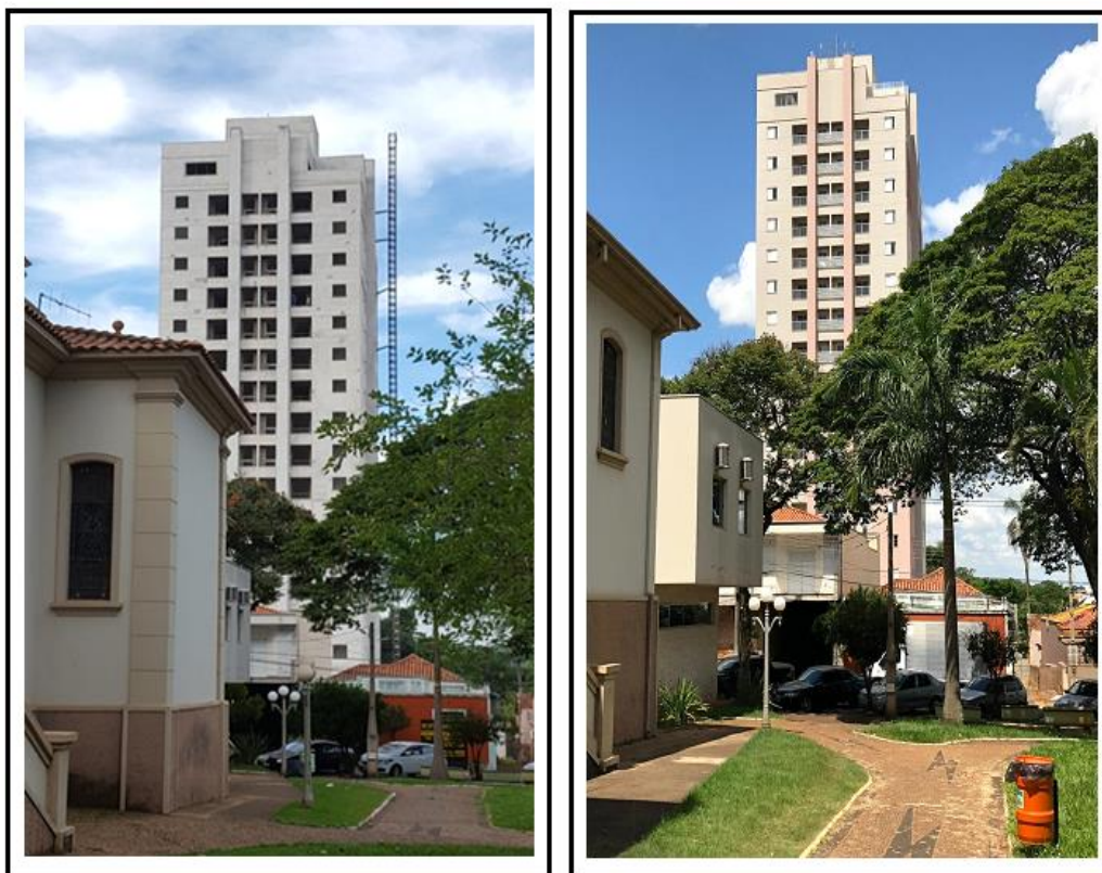
Foto 05: Edifício residencial em construção e em fase de conclusão - centro de Iracemápolis
