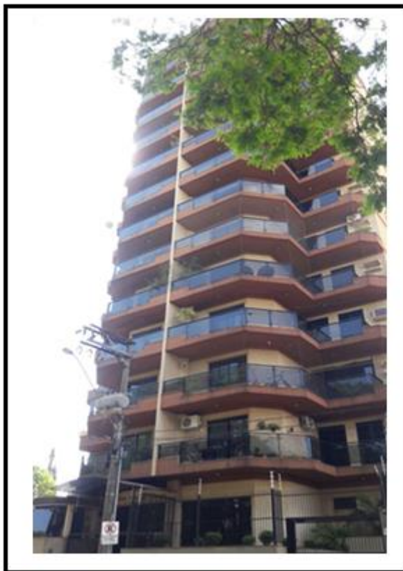
Foto 06: Edifício residencial - Centro de Iracemápolis
