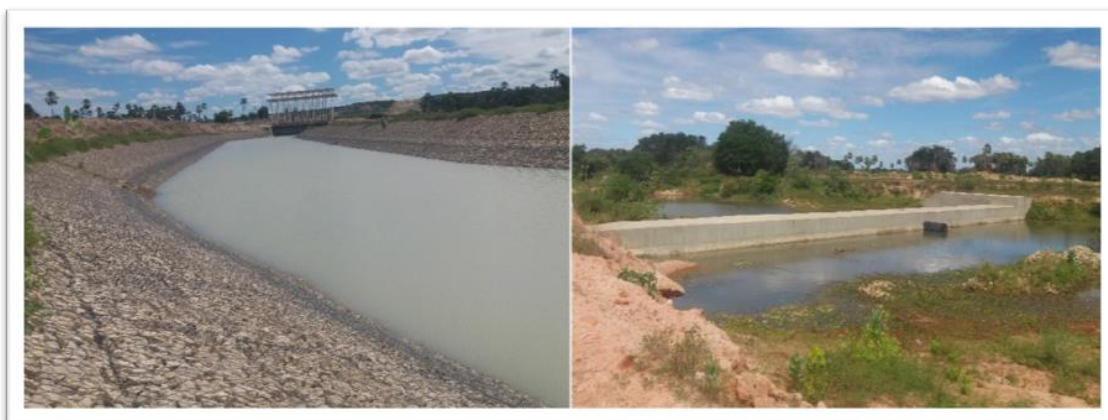
Figura 26. À esquerda, Estação elevatória para levar água do rio Apodi para a Chapada. À direita, Barramento do Rio Apodi
