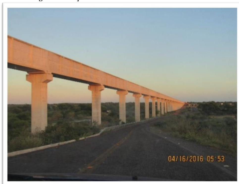
Figura 8. Estação elevatória do PI Pontal em Petrolina-PE
