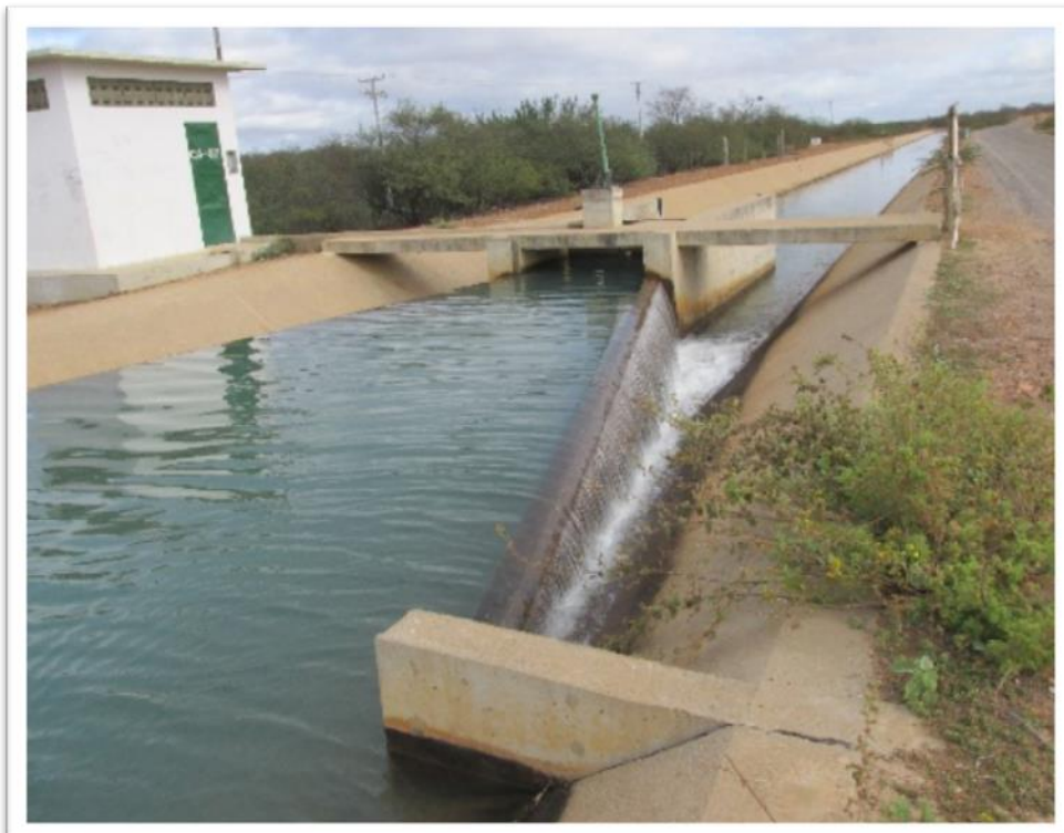
Figura 6. Tecnologia de redução de fluxo da água do canal, no PI Pontal
