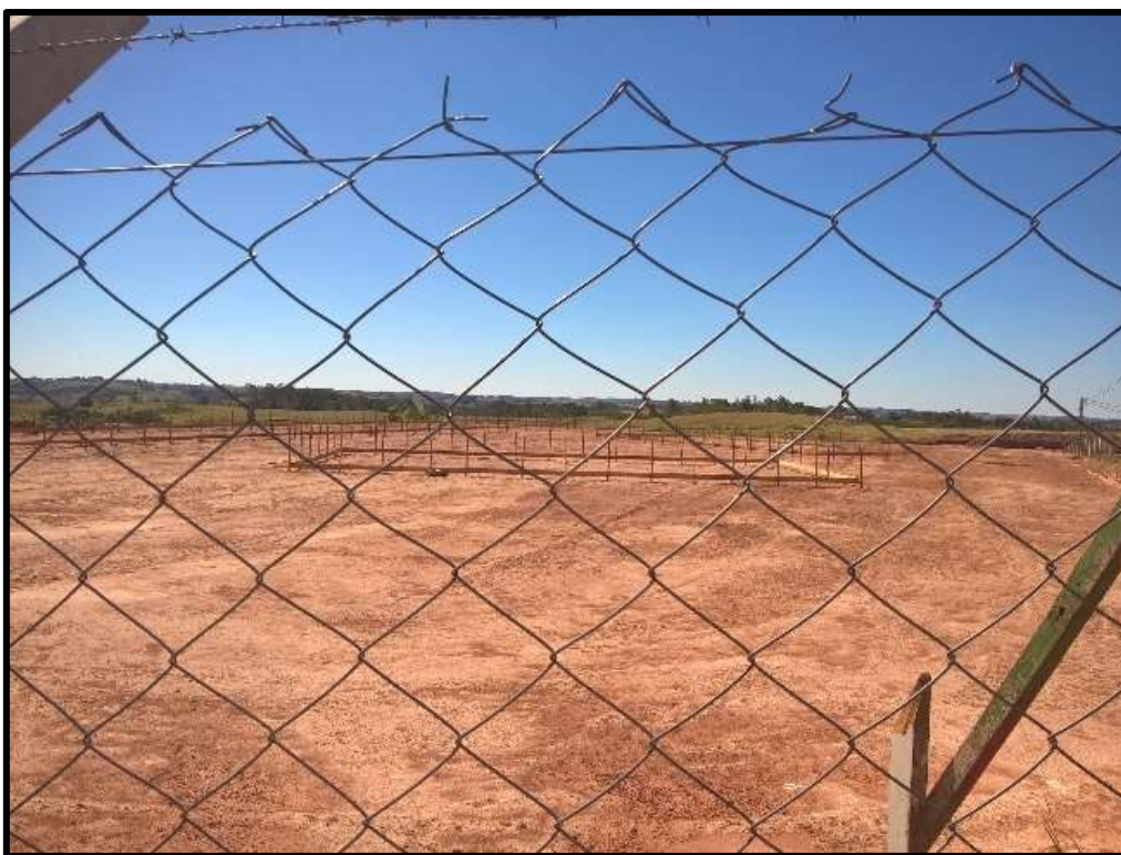
FOTO 33 – Área na qual a Unidade Escolar de Ensino Fundamental será construída, Conjunto Habitacional João Domingos Netto, Presidente Prudente, 2017.
