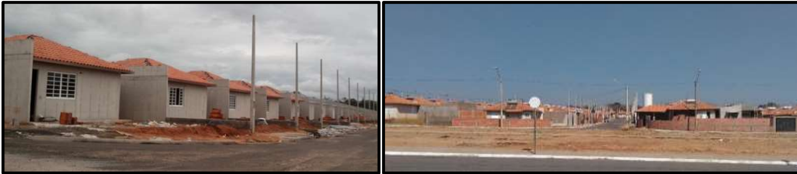
FOTO 45 e FOTO 46 – Canteiro de obras do Residencial Eduardo Abdelnur, São Carlos, com os muros laterais previamente demarcados, 2016 e 2017.
