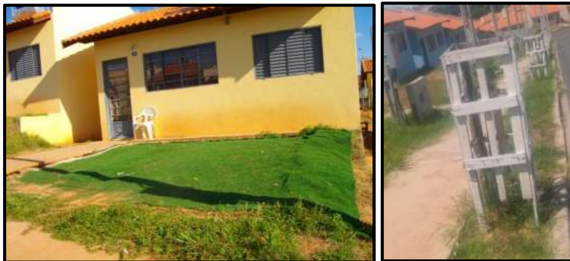
FOTO 49 - Residencial Bela Vista, Presidente Prudente: fachada com a divisão lateral previamente demarcada em apenas uma das laterais, calçada e quintal sem pavimentação, 2015.
