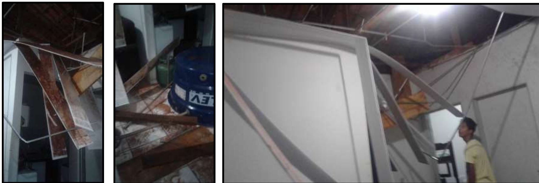
FOTO 34, FOTO 35 e FOTO 36 – Destruição causada pelo desabamento de caixa d'água em residência do Conjunto Habitacional Jardim João Domingos Netto, Presidente Prudente, 2016.
