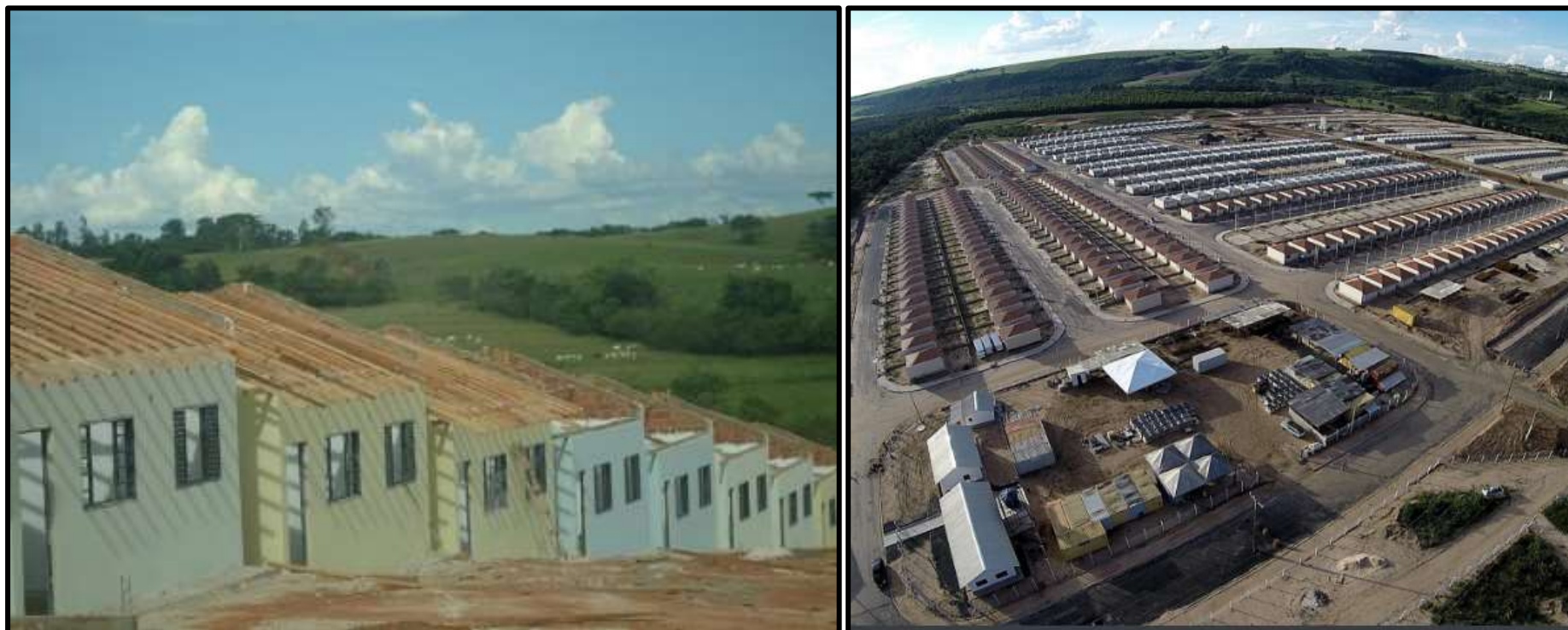
FOTO 7 - Canteiro de obras das unidades habitacionais do Conjunto Habitacional Jardim João Domingos Netto, Presidente Prudente, 2014.
