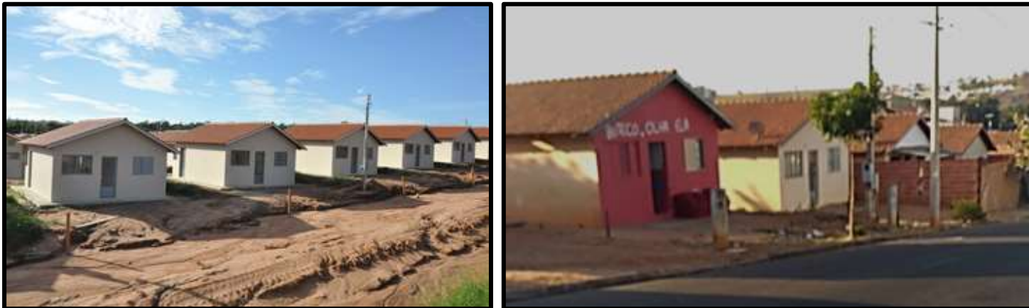
FOTO 47 e FOTO 48 – Jardim Zavaglia em São Carlos: sem muros laterais e sem calçadas pavimentadas, 2011 e 2017.
