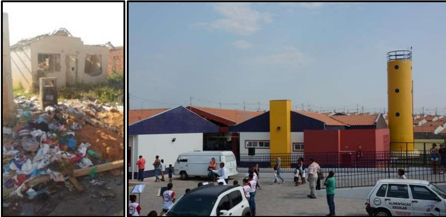
FOTO 10 – Casa abandonada no Jardim Zavaglia, São Carlos, 2017.
