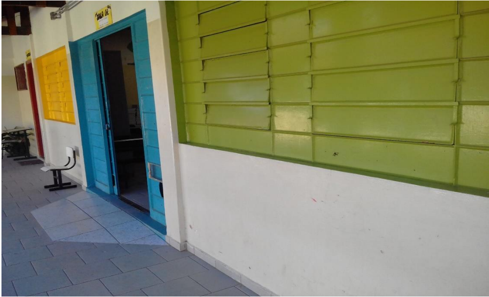
Figura 5 – Luminosidade de uma sala de aula da escola catorze
