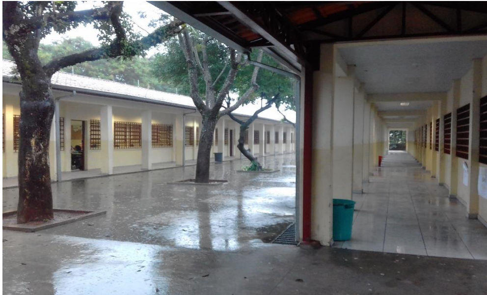
Figura 4 - Interior da escola quatro
