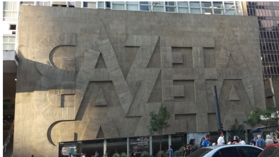
Figura 39 - Relevo em concreto
