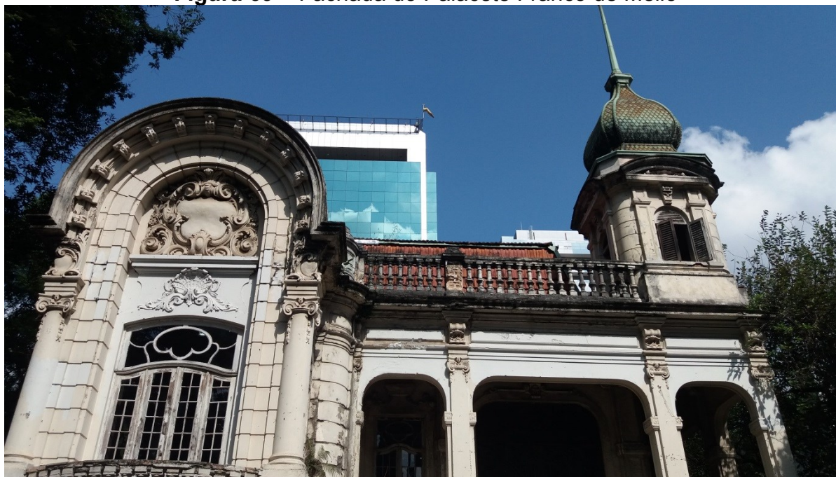
Figura 69 – Fachada do Palacete Franco de Mello
