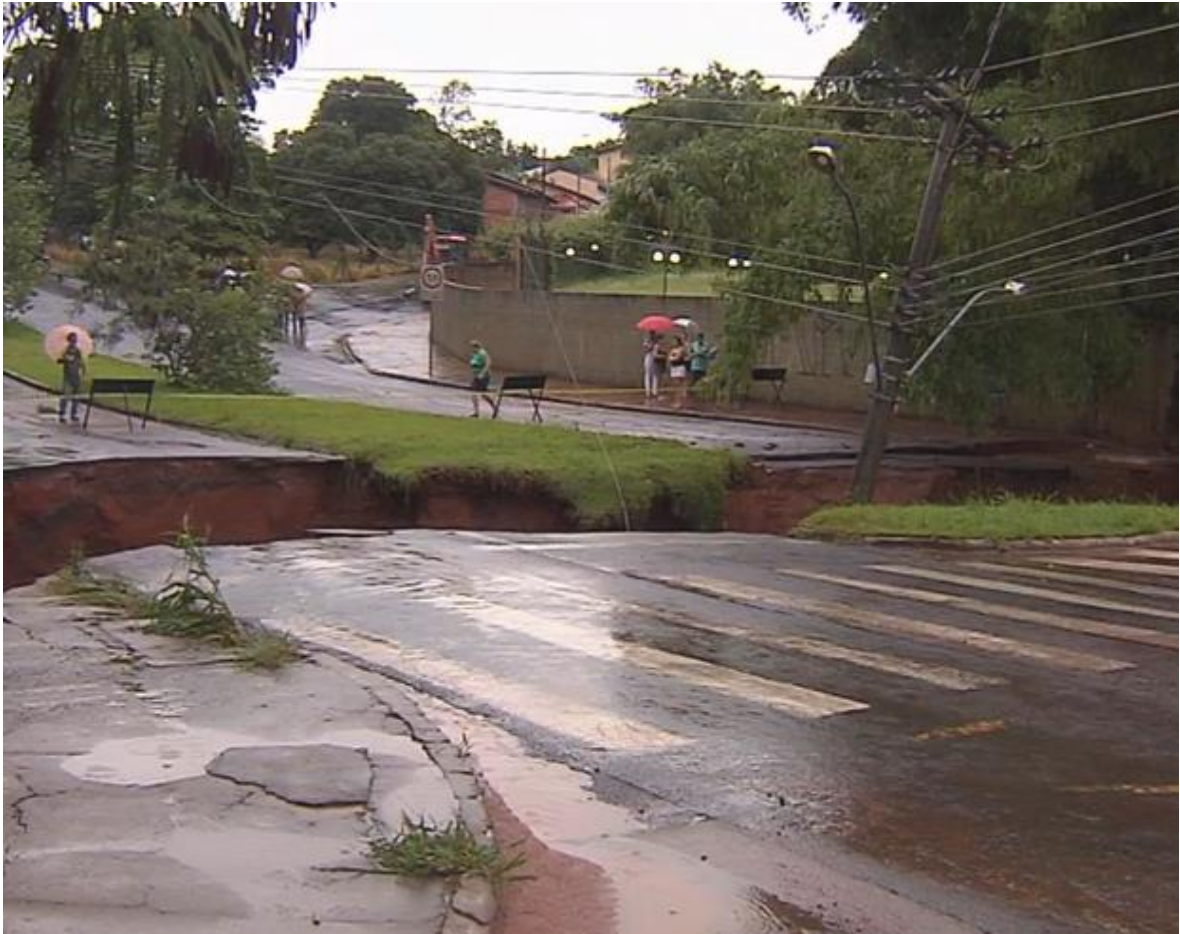
Figura 7 - Cratera aberta após fortes chuvas na Avenida Otto Ribeiro, na região central de Assis, resultando na morte de uma pessoa.
