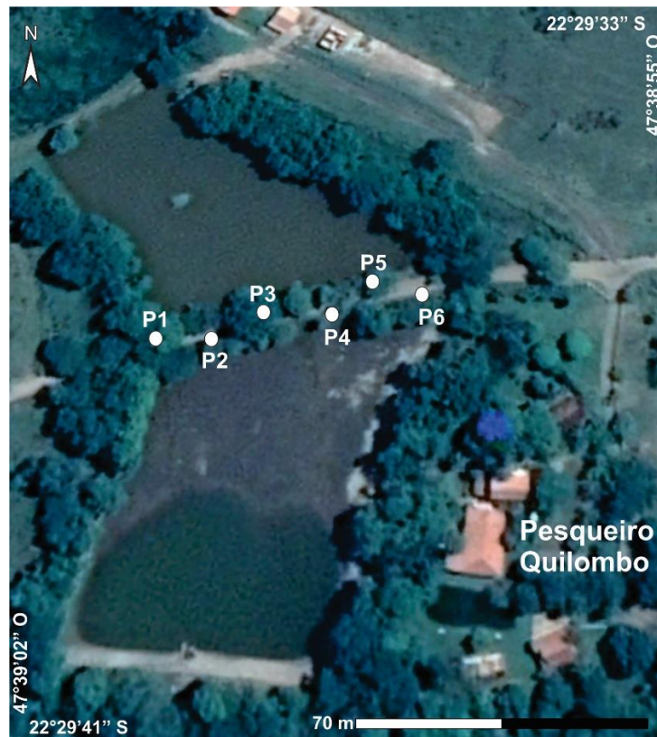
Figura 5.6 – Localização dos pontos dos ensaios de permeabilidade na barragem de Ipeúna.
