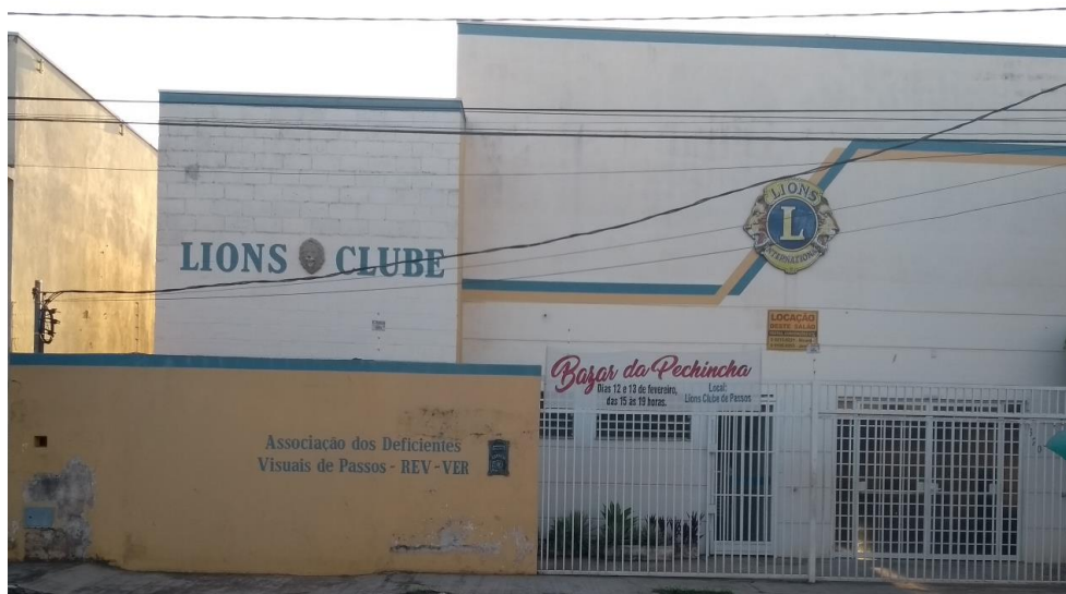
Figura 8 - Vista da fachada da Associação dos Deficientes Visuais de Passos/MG.
