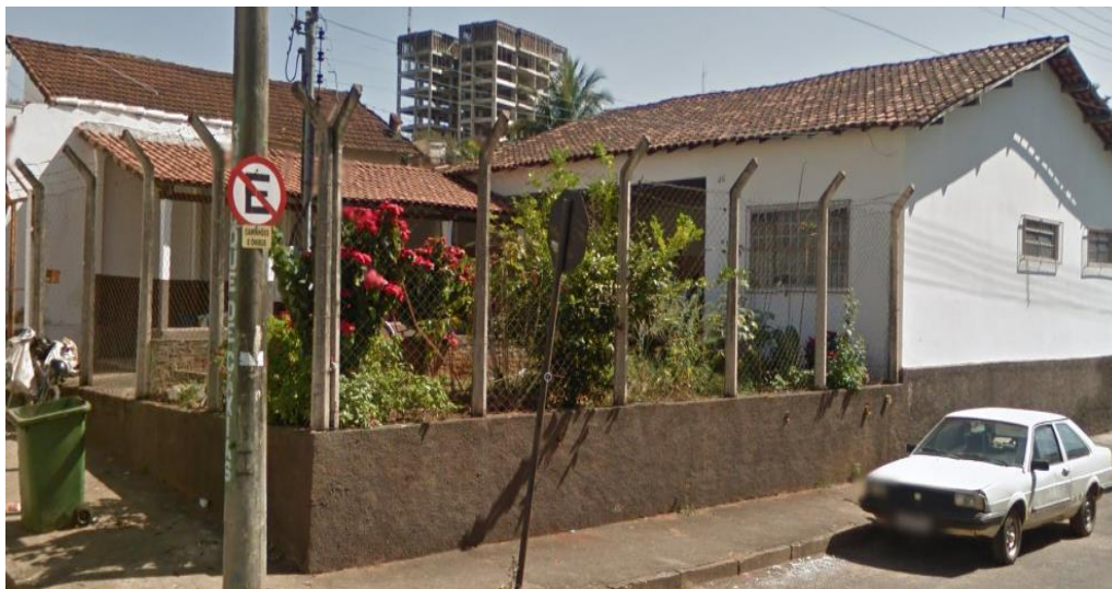
Figura 9 - Vista da fachada da Casa Padre Léo de Passos/MG.
