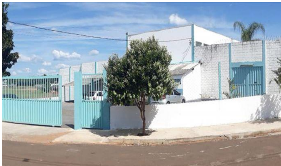
Figura 2 - Vista da fachada da Associação de Proteção e Assistência aos Condenados de Passos/MG.
