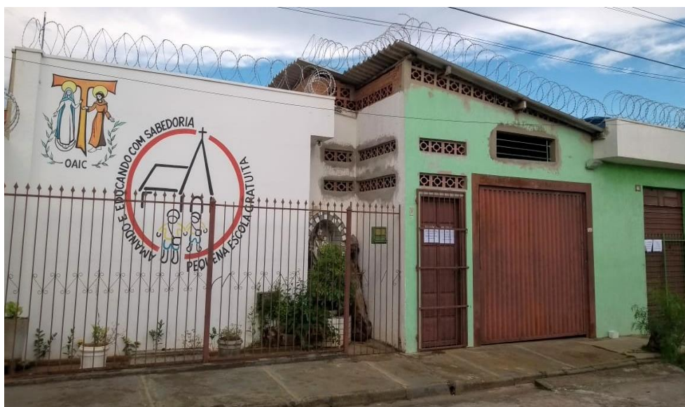
Figura 6 - Vista da fachada da Associação Pequena Escola Gratuita São José de Passos/MG.
