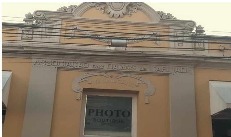
Figura 1 - Vista da fachada do prédio “Associação das Damas da Caridade” localizado no centro de Passos/MG.
