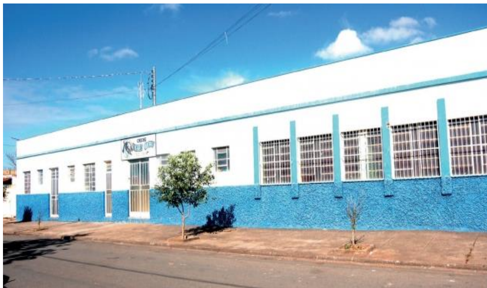
Figura 13 - Vista da fachada da SERVIRÁS - Associação de Assistência Social de Passos/MG.
