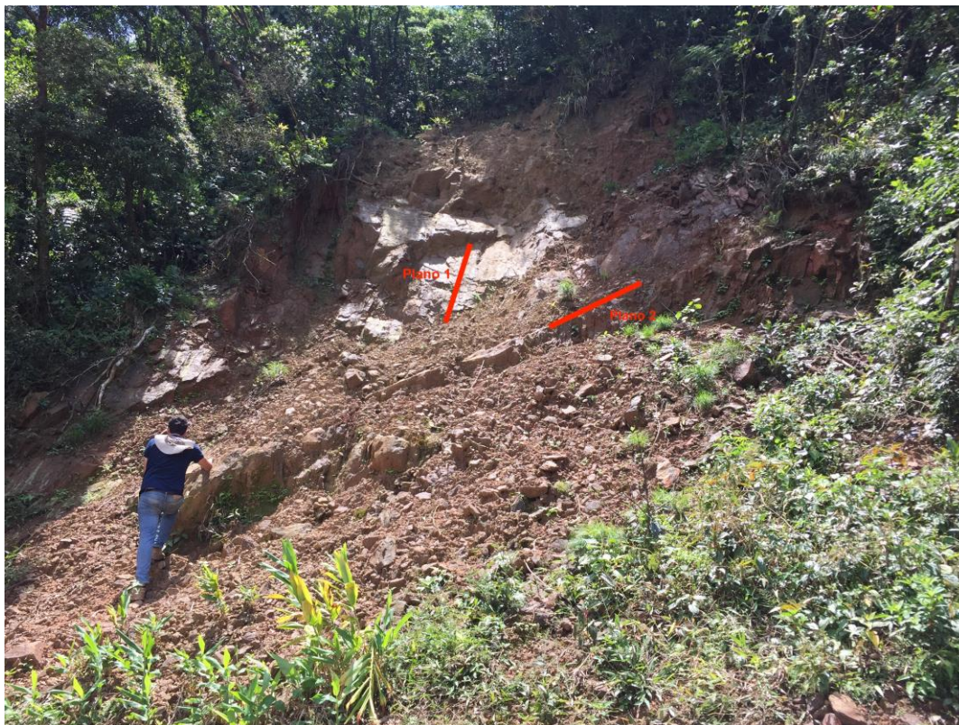
Figura 8 - Imagem de um escorregamento em forma de cunha no município de Cubatão – São Paulo, na Estrada Caminhos do Mar.
