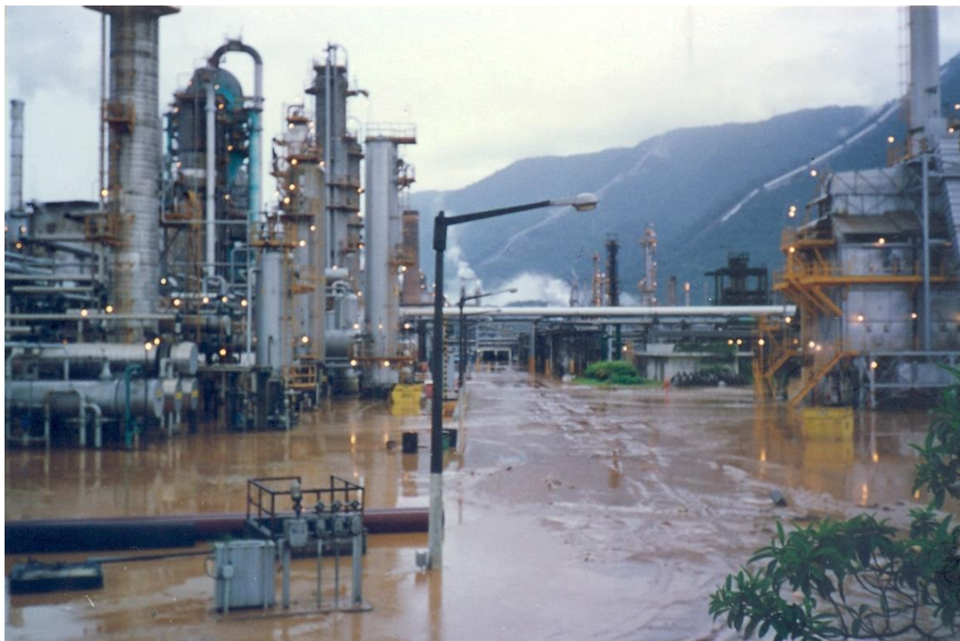
Figura 11 - RPBC e sua unidade de processamento de produtos inundada (Vertente Norte) – fevereiro de 1994.
