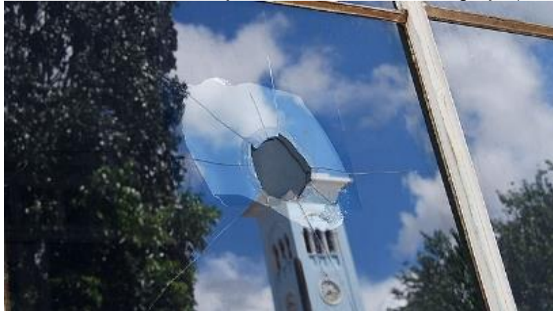
Figura 14: Janela quebrada. Foto tirada em uma casa na Rua 09, na lateral da Praça da Santa Cruz. Refletido no vidro da janela se vê a torre da Igreja (SALLES, 2012).
