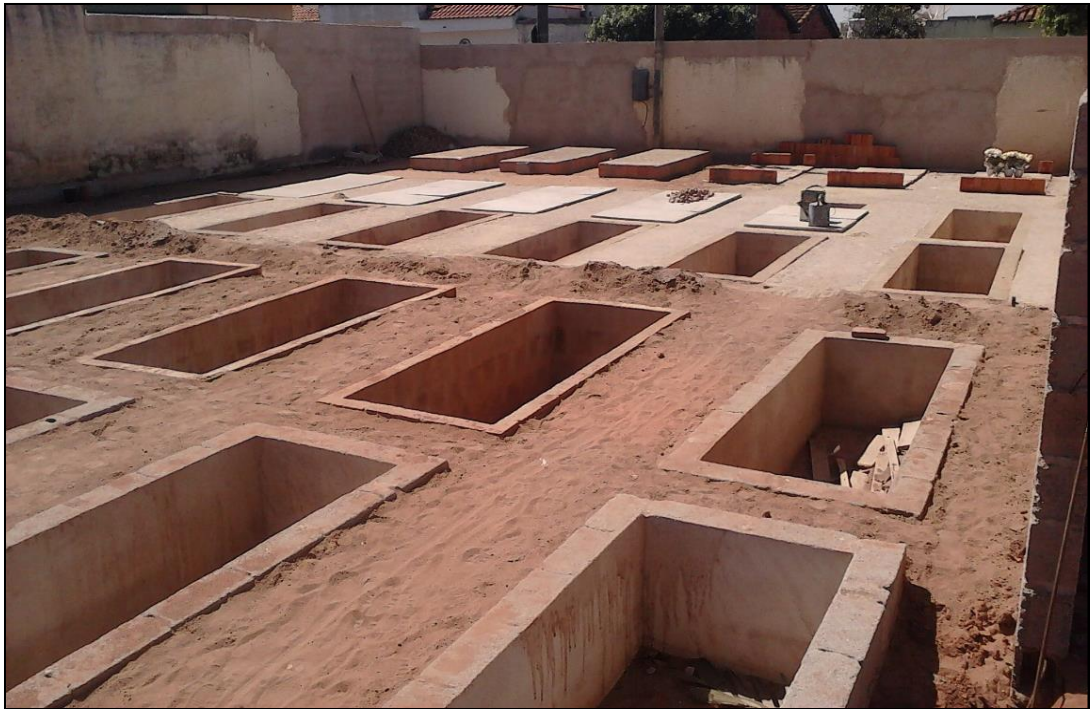
Figura 05: Área nova do cemitério sendo construída, com covas individuais construídas em alvenaria.
