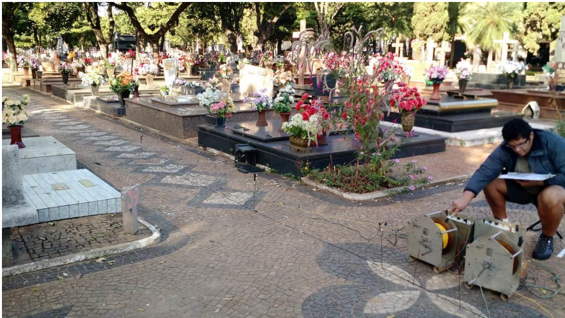
Figura 20: Equipamento e execução de uma SEV no Cemitério da Saudade
