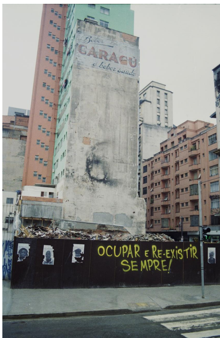
Figura 27: Escombros do Edifício Wilton, 2018, Minota, 50mm, Kodak Proimage, ISO100
