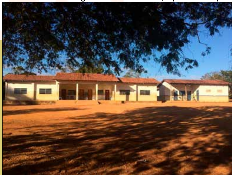
Figura 11: Escola Estadual Indígena Wakōmēkwa, após 2ª etapa da construção
