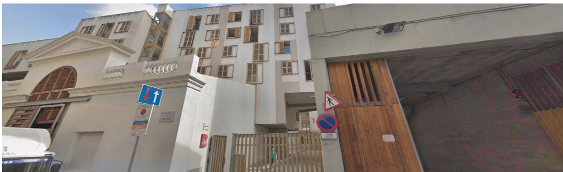
Figura 153 - Entrada da Vivienda, acesso pela Carrer de Freixures
