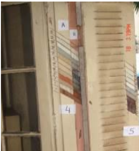
Figura 31 — Processo de descascamento do edifício para identificação da colorimetria original da edificação
