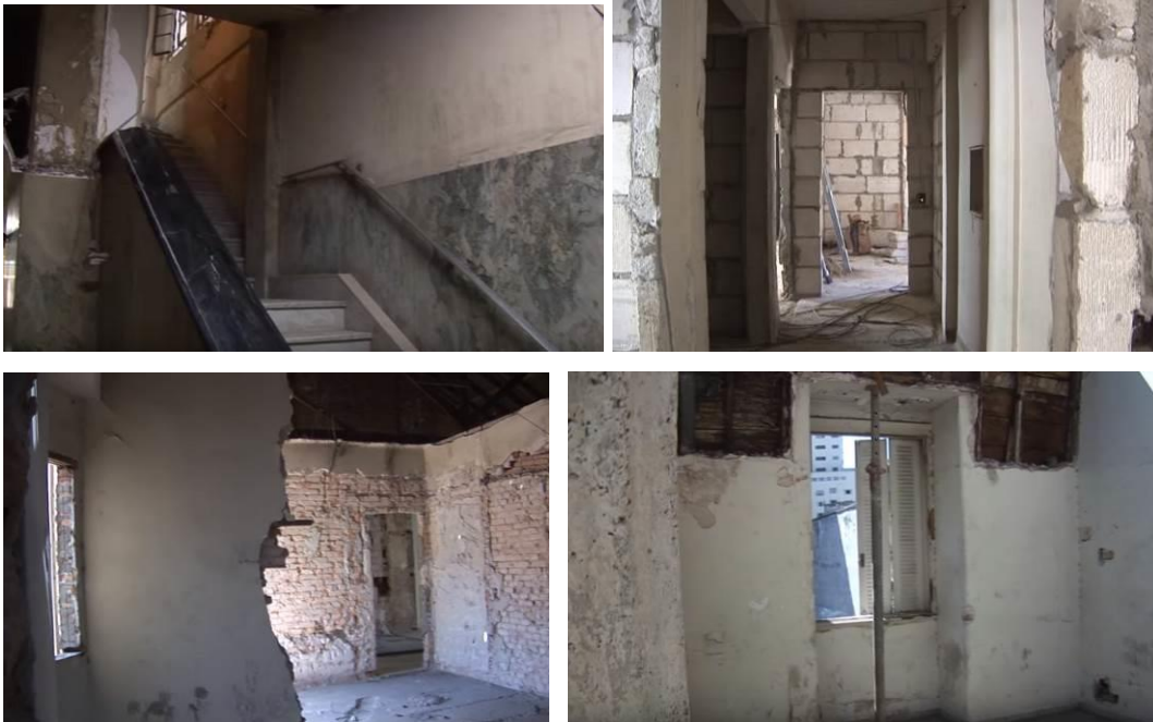
Figura 20 — Interior do Edifício Cineasta após degradação
