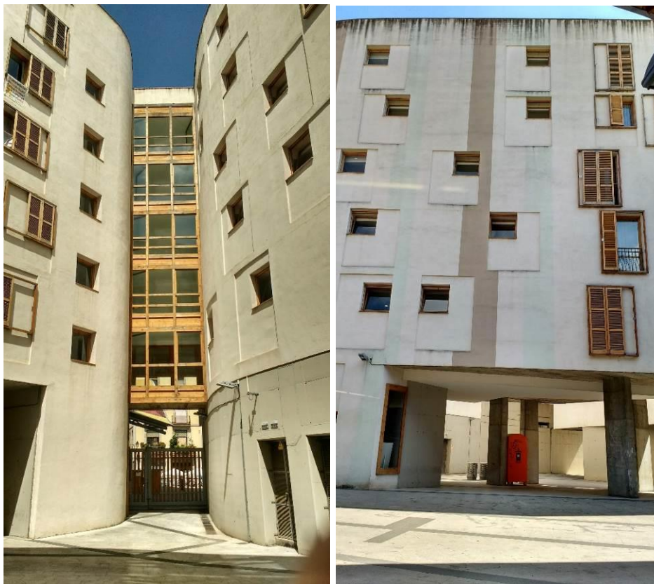
Figura 162 — Detalhe do corredor entre blocos da Vivienda de Santa Caterina e Fachada posterior
