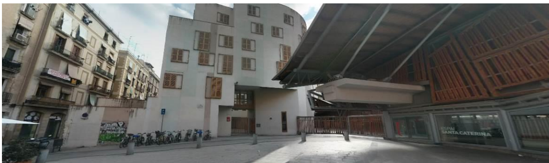
Figura 151 — Entrada da Vivienda, acesso pela Carrer D'En Giral el Pellicer
