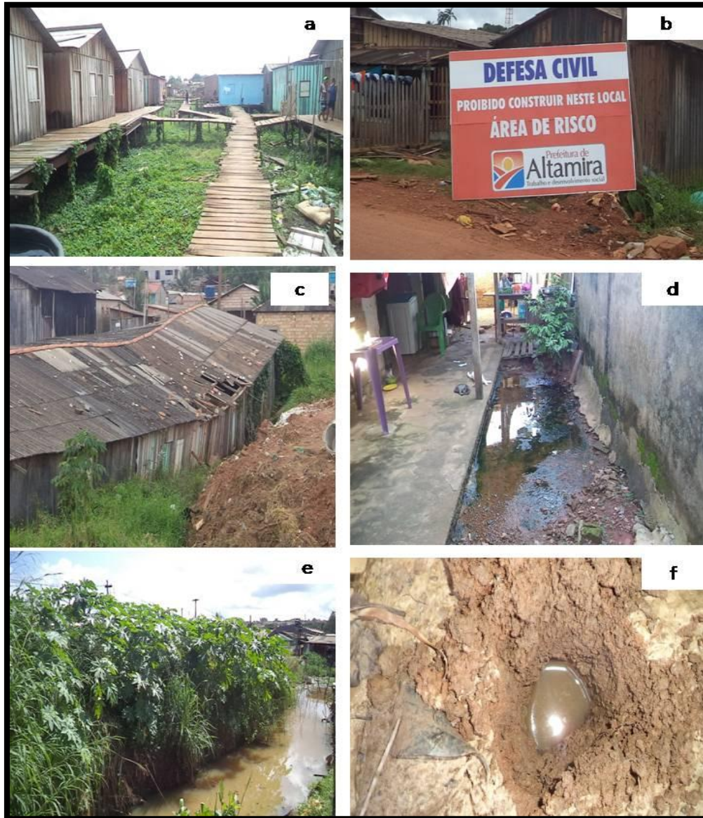
Figura 132: Vista da ocupação desordenada da lagoa no bairro Independente I; (b) Instalação de placa pela Prefeitura Municipal de Altamira na Rua Abel Figueiredo proibindo a ocupação; (c) Desabamento de casas; (d) Surgimento de nascentes no interior das residências; (e) Abertura de valas e instalação de bomba de sucção de água para minimizar o problema de inundações; (f) Coleta de amostra no quintal da casa atestou presença de água a poucos centímetros da superfície.
