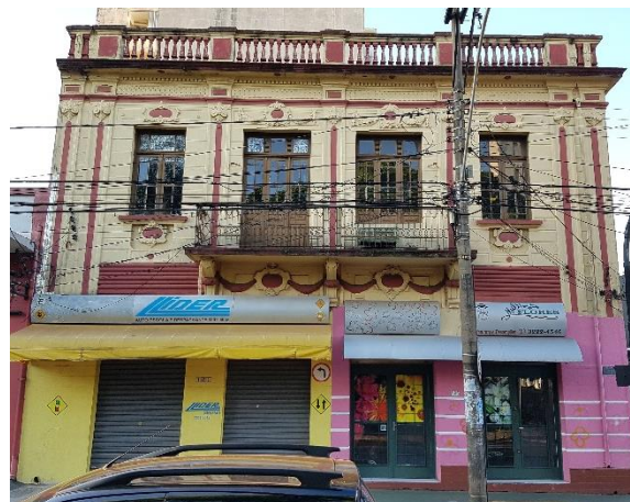
d) Edificação na rua 1º de Agosto.
