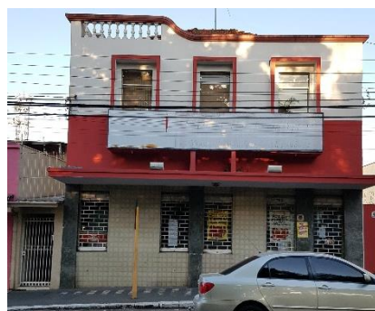
f) Edificação na rua Antônio Alves.
