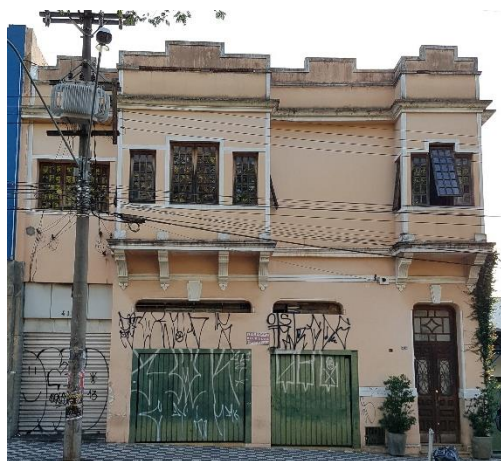
b) Edificação na rua Gustavo Maciel.
