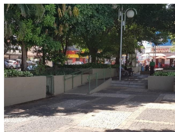
j) Acessibilidade implementada em 2015, conforme NBR 9050; canteiros elevados que bloqueiam a visão dos usuários.
