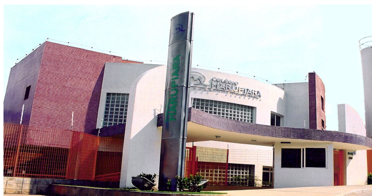
Figura 5: Vista frontal do Colégio Marupiara - entrada principal
