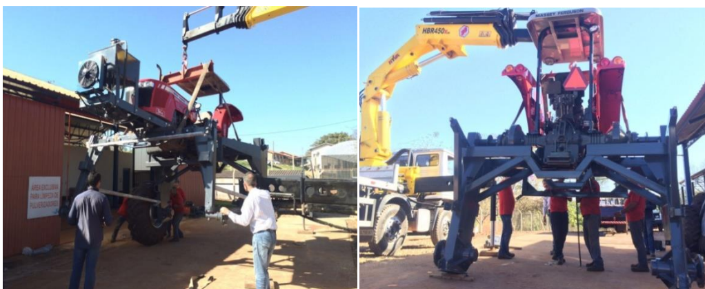
Figura 8 – Montagem da máquina compostadora
