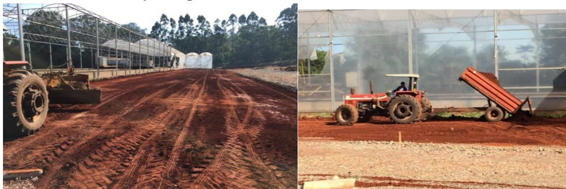
Figura 3 – Compactação e nivelamento do terreno para construção da estufa de compostagem
