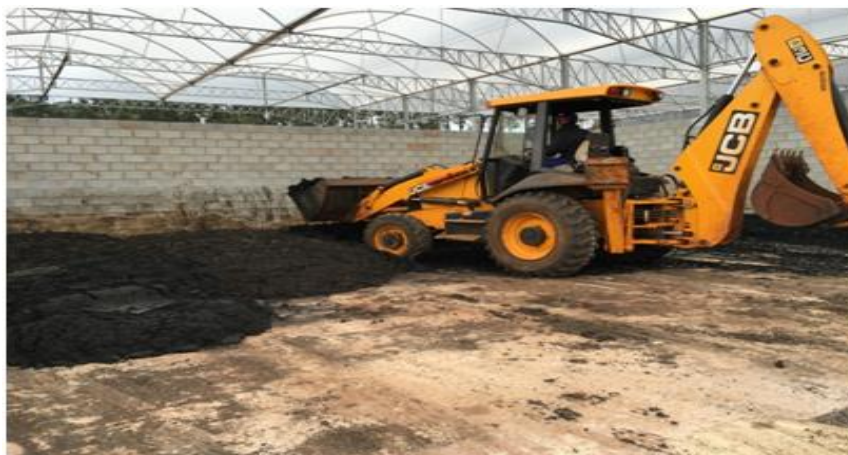
Figura 5 – Baia com piso concretado para depósito de lodo de esgoto
