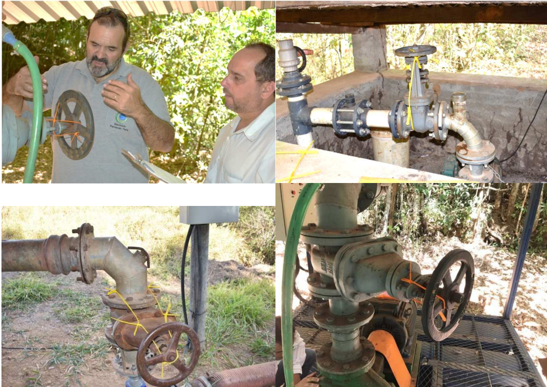
Figura 15 – Lacração dos equipamentos de captação
