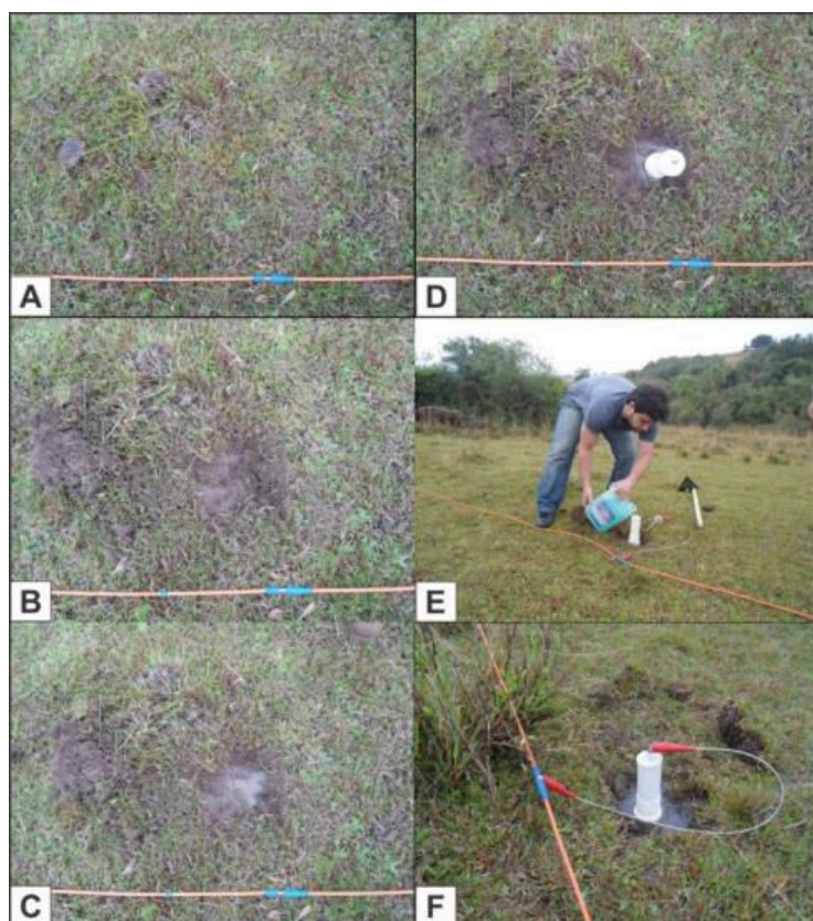
Figura 7.2 - Etapas percorridas desde a disposição do cabo até a fixação e preenchimento dos eletrodos. Fonte: Cortes (2015).
