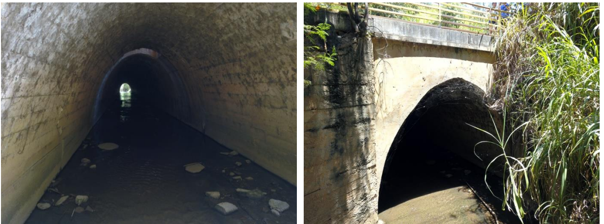
Figura 6-20. Vista do Túnel (fevereiro/2019) Autoria Pessoal.
