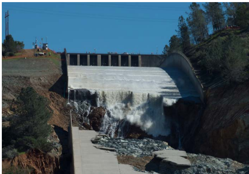
Figura 2 – Erosão na estrutura de concreto do vertedouro da barragem de Oroville
