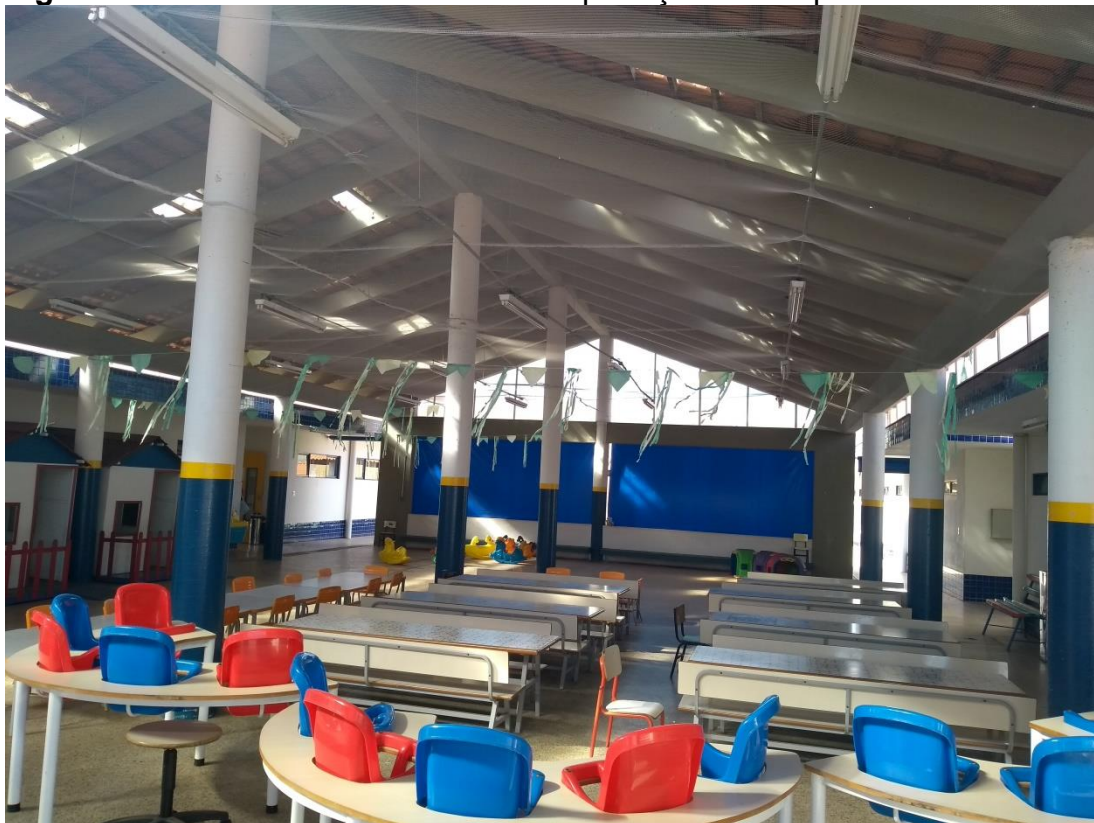
Figura 23 - Pátio Coberto com a tela de proteção contra pássaros instalada.
