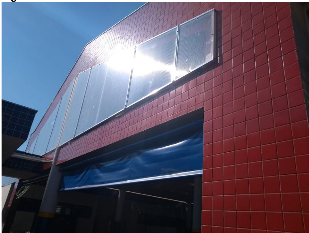
Figura 24 - Aberturas do Pátio Coberto vedadas com material acrílico.
