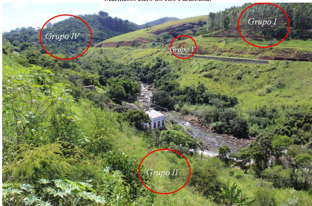
Figura 106 – Grupos de Fácies mapeados próximo à foz do ribeirão Marmelos – setor de construção da Usina Marmelos Zero no Rio Paraíba.
