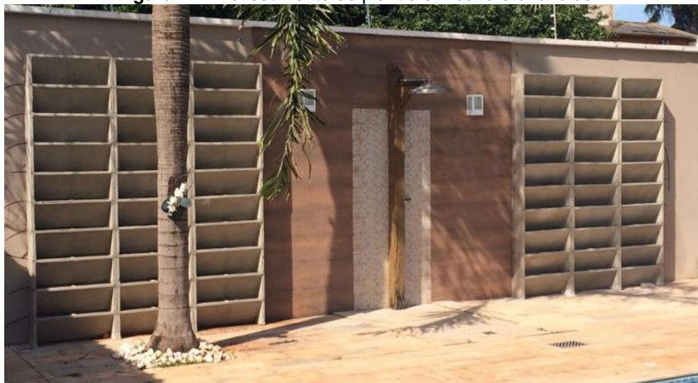
Figura 14. Revestimento de plantio em concreto fundido
