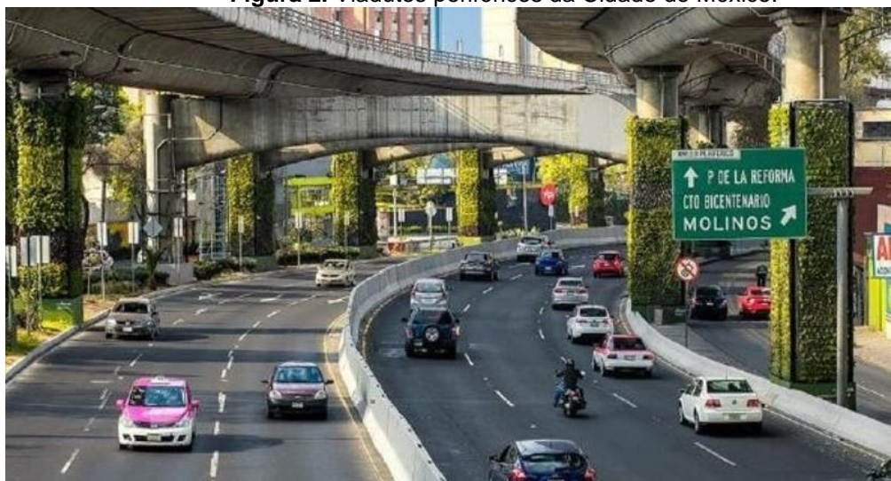
Figura 2. Viadutos periféricos da Cidade do México.
