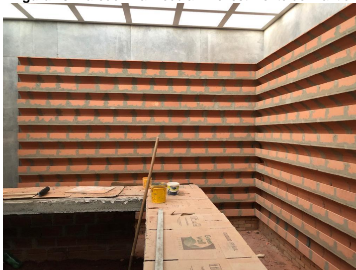
Figura 13. Parede viva modular- Revestimento de Plantio
