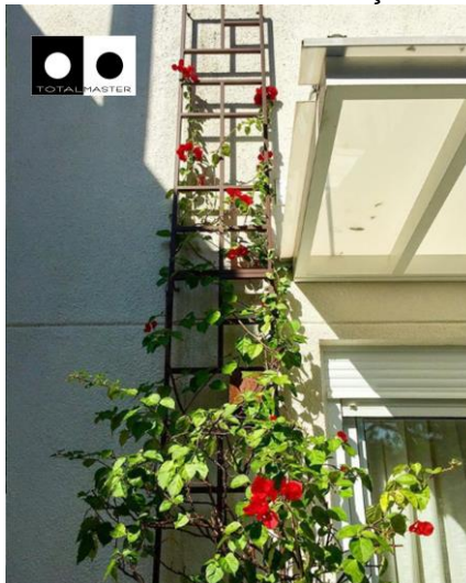
Figura 10. Fachada Verde Indireta- Treliza Modular
