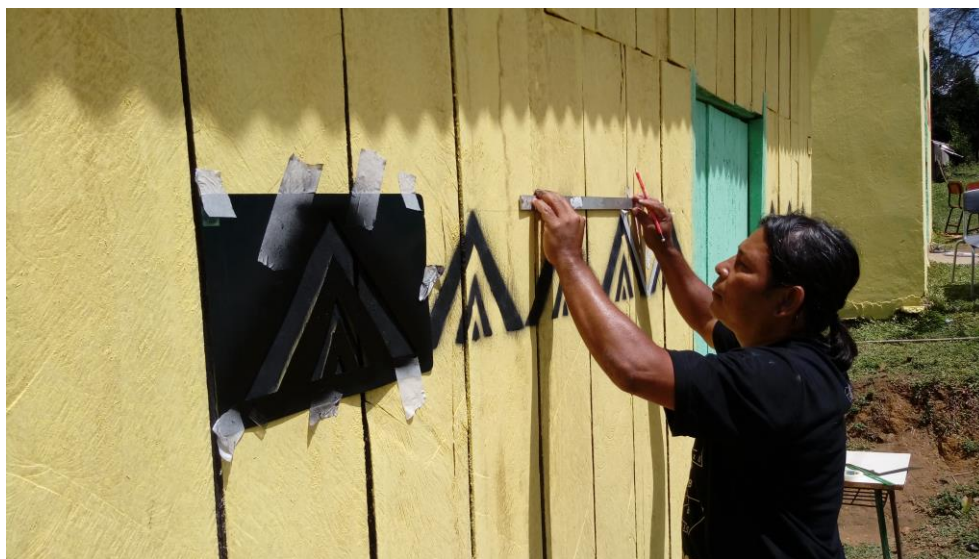
Figura 47 – Katu Tupinambá aplicando a técnica de pintura do stencil na parede da escola indígena tupinambá da Aldeia Abaeté. Foto: Luis Quesada, 2017.
