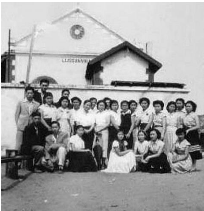
Figura 33– Passageiros no pátio da Estação ferroviária Lussanvira, 1938
