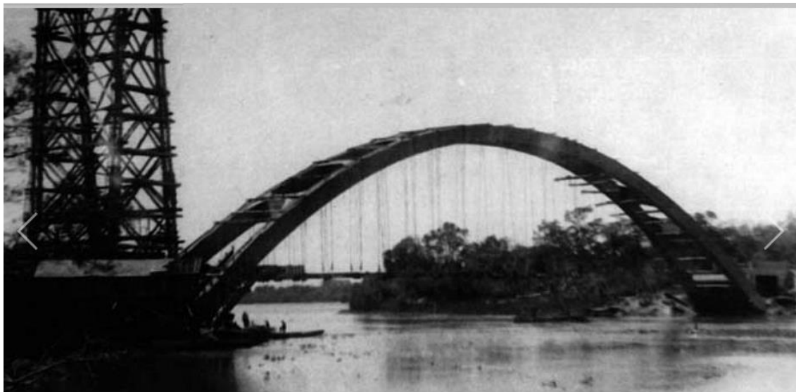
Figuras 15: Construção do arco da ponte Novo Oriente, 1934
