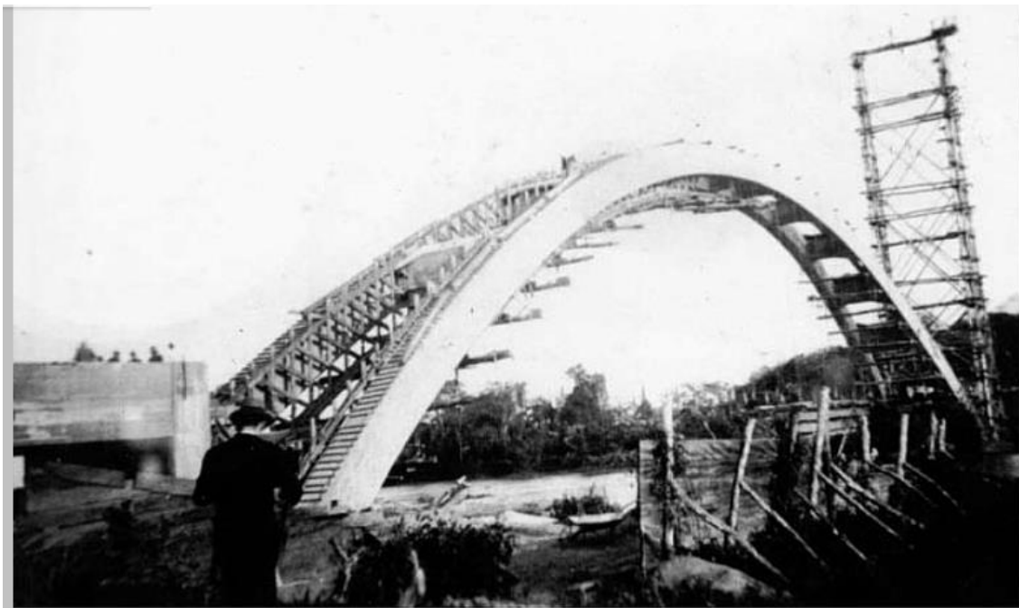
Figura 37: Construção do arco da ponte Novo Oriente, 1934
