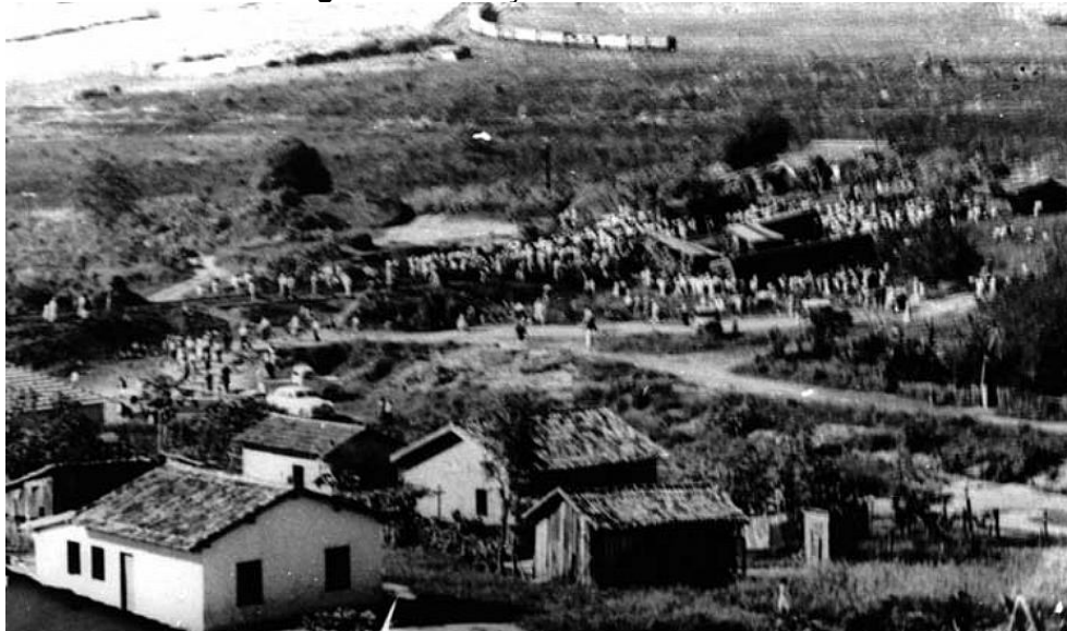
Figura 34– Estação ferroviária Lussanvira - 1928
