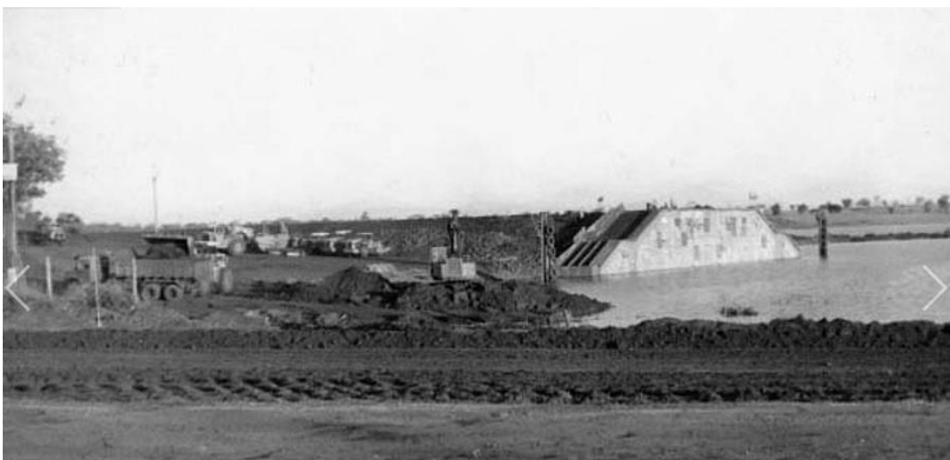
Figura 23: Porto de Areia, antes do represamento, Pereira Barreto, s/d
