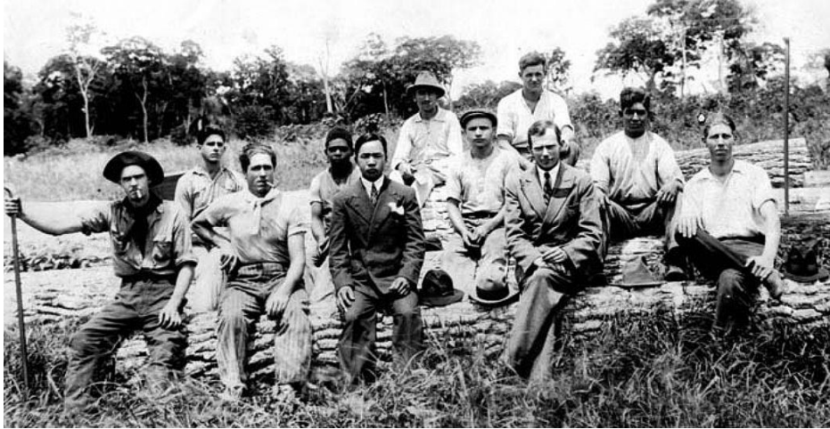
Figura 35– Início do Desbravamento,1928
