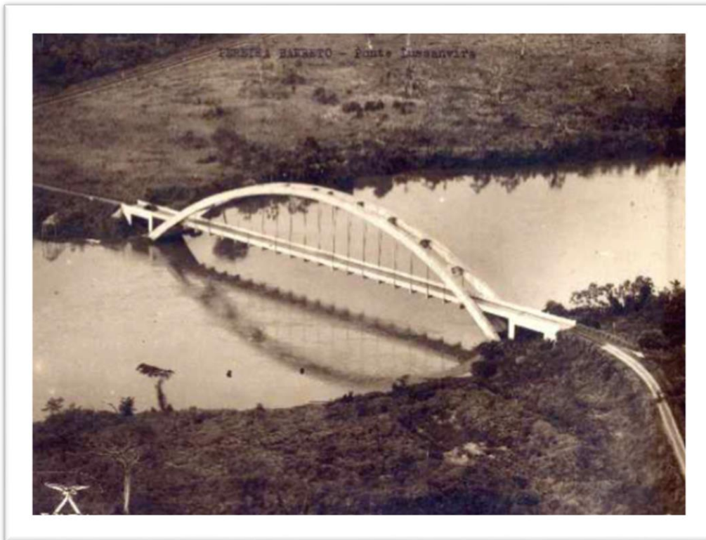
Figura 16: Ponte Novo Oriente – Pereira Barreto/SP . Ligação entre a área central do futuro município e a estação ferroviária Lussanvira. 1939-40/ Tombo 2538
