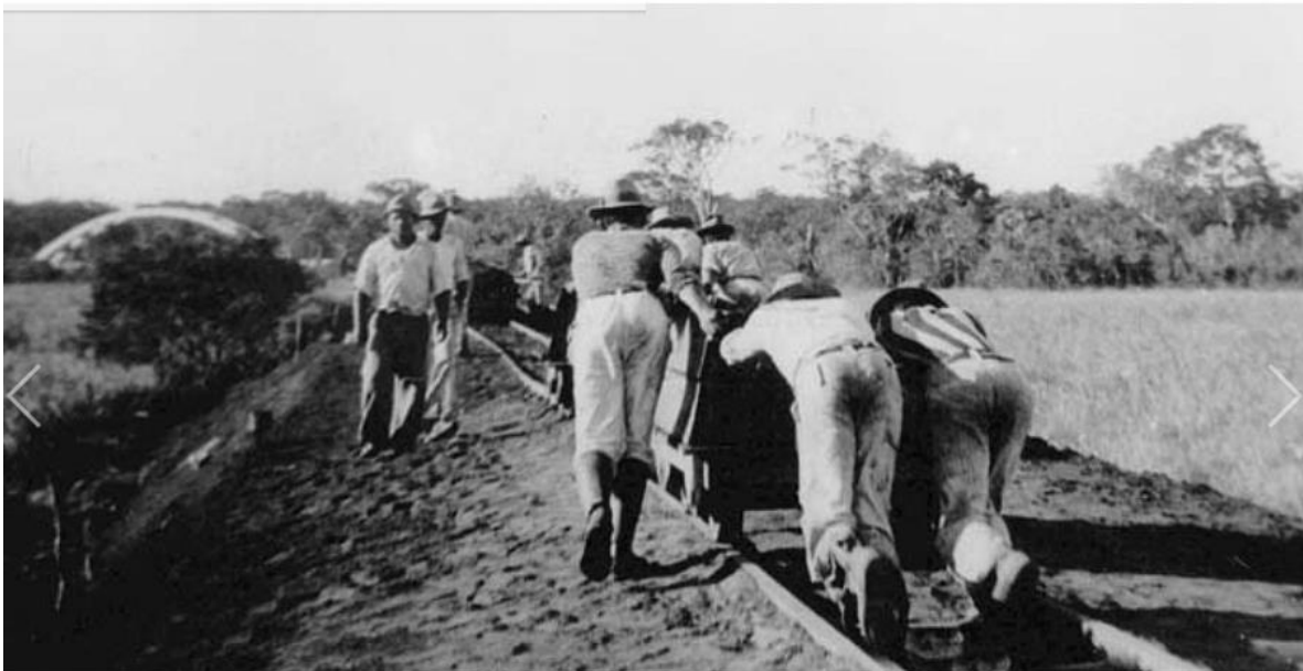
Figura 36: Construção do aterro para a ponte Novo Oriente, 1932
