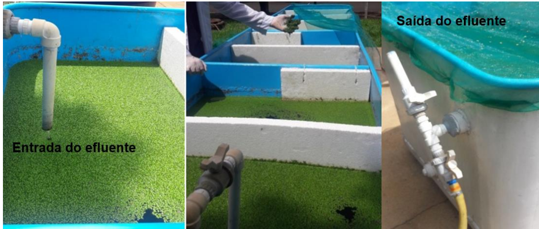
Figura 16 - Tanque de lemnas com as seções, entrada e saída do efluente
