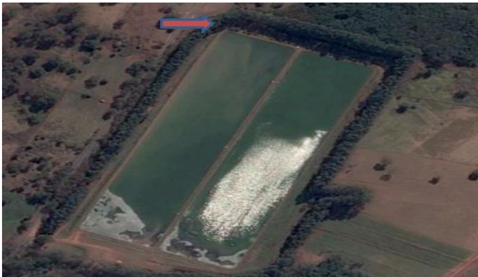
Figura 18 - Vista aérea da Estação de tratamento de Esgoto de Ilha Solteira-SP
