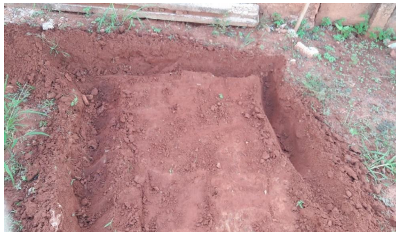
Figura 27 - Preparo das canaletas para deposição da mistura
