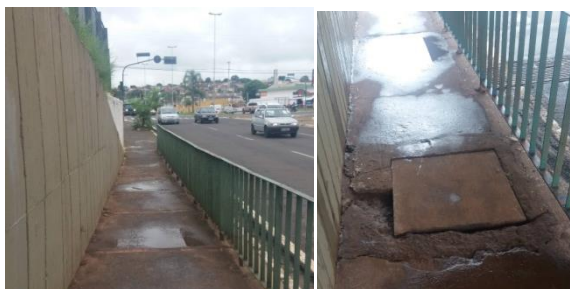
Figura 93: Passagem de Pedestre sob o a linha férrea
