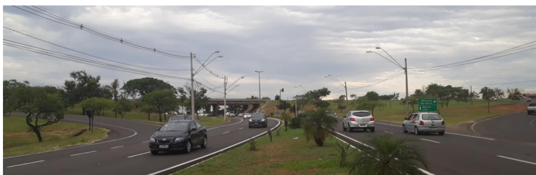
Figura 20: Vista da Rodovia Marechal Rondon a partir da Avenida Nações Unidas.
