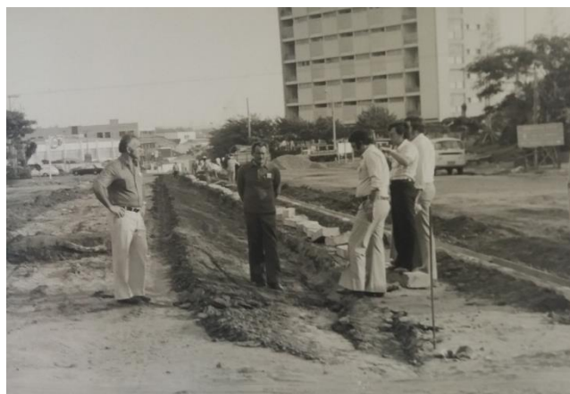
Figura 9: Construção da via Nações Unidas próxima ao Edifício Brasil-Portugal.
