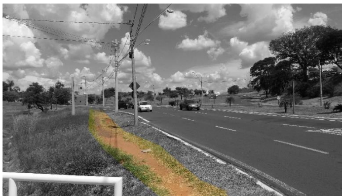
Figura 31: Passagem de pedestre em área sem pavimentação.
