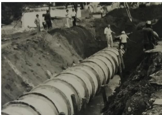
Figura 48: Canalização do Córrego das Flores
