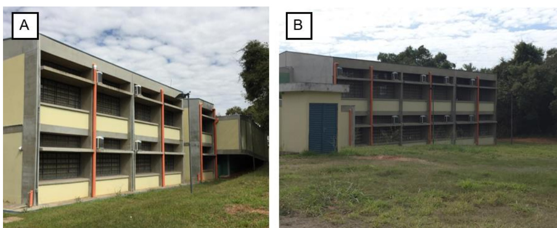
Figura 12 – Departamento de Ciências Humanas: a) Fachada NNE; b) Fachada SSO
