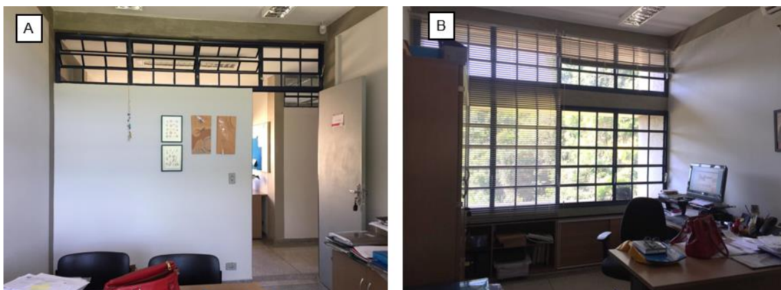
Figura 9 – Interior típico dos prédios: a) Vista para o corredor; b) Vista para o exterior
