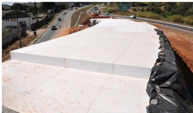
Figura 3 – Encontro de viaduto em Jundiaí/SP
