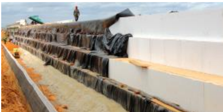
Figura 4 – Encontro de ponte na BR 101, divisa PB e PE
