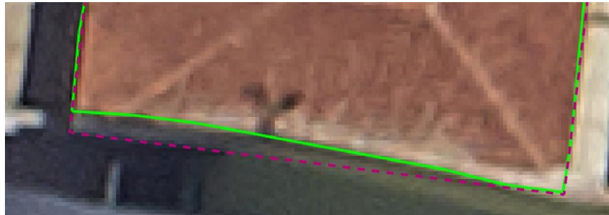
Figura 48 – Detalhe da mancha branca no telhado que atrapalhou o delineamento correto da borda, contorno detectado (verde) e contorno correto (rosa tracejado).
