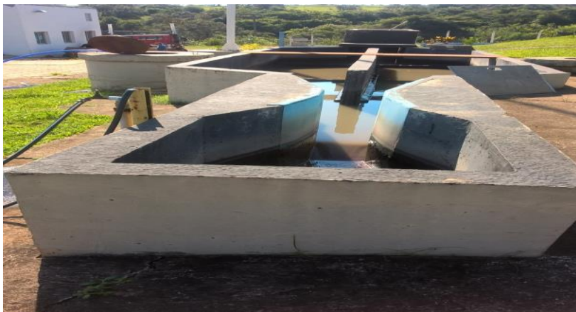
Figura 15 – Detalhe da Calha Parshall
