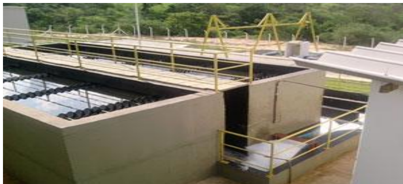
Figura 19–Detalhe do decantador secundário
