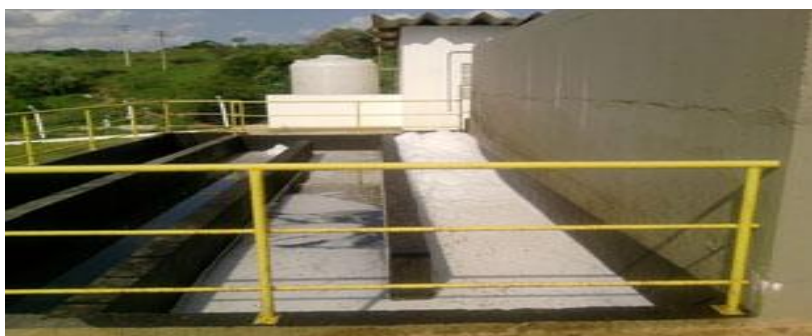
Figura 20 – Detalhe do Sistema de cloração
