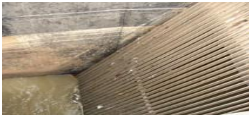
Figura 14 – Etapa do Gradeamento da estação
