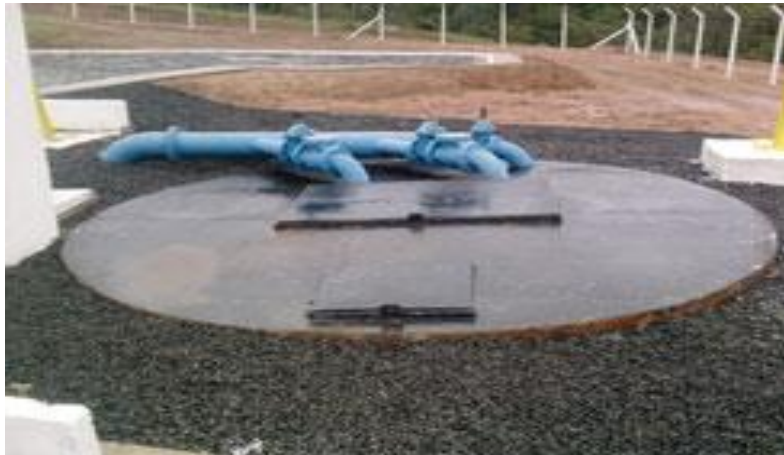
Figura 13 – Estação elevatória da ETE Candeia
