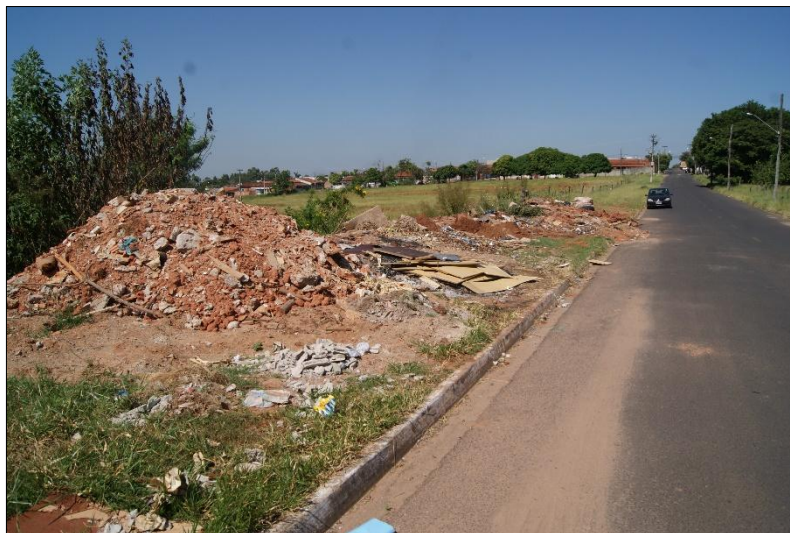
Figura 89 - Aspectos de área com processos erosivos atingindo as ruas, destaque para o sistema de contenção com entulhos.
