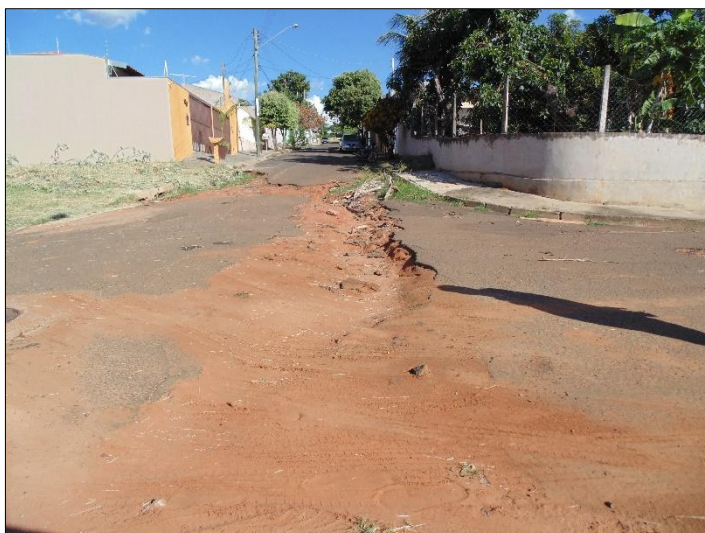
Figura 117 - Aspectos do P4ZL, com destaque para desgastes no asfalto no sentido do declive.
