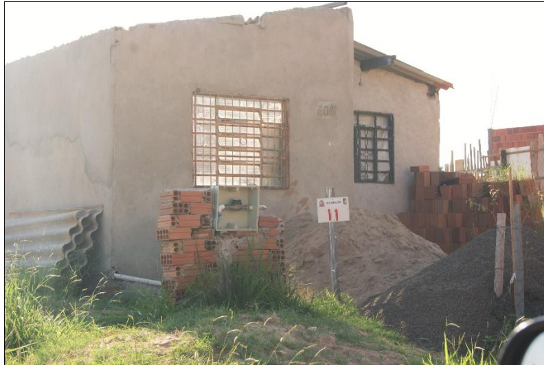
Figura 76 - Aspectos moradias em construção no ponto 6, destaque para organização habitacional feita Prefeitura Municipal.
