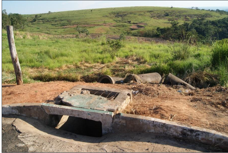
Figura 82 - Ponto 7 a jusante da área urbana, pastagem e na cobertura vegetal arbustiva próxima a escarpa. Observa-se também a degradação da tubulação de captação de águas pluviais.
