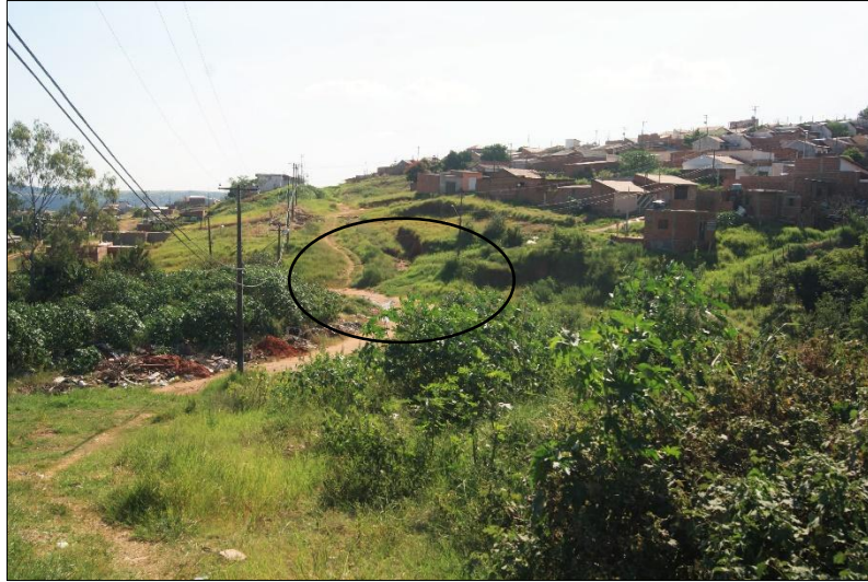
Figura 67 - Aspectos gerais do P5ZS, destaque para áreas com processos erosivos (área urbana em alta e média vertentes).
