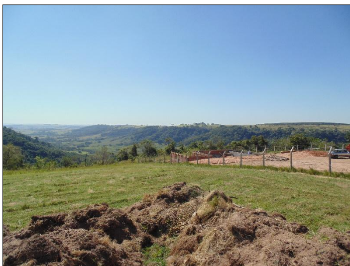
Figura 100 - Aspectos gerais do ponto 1 (construções)
