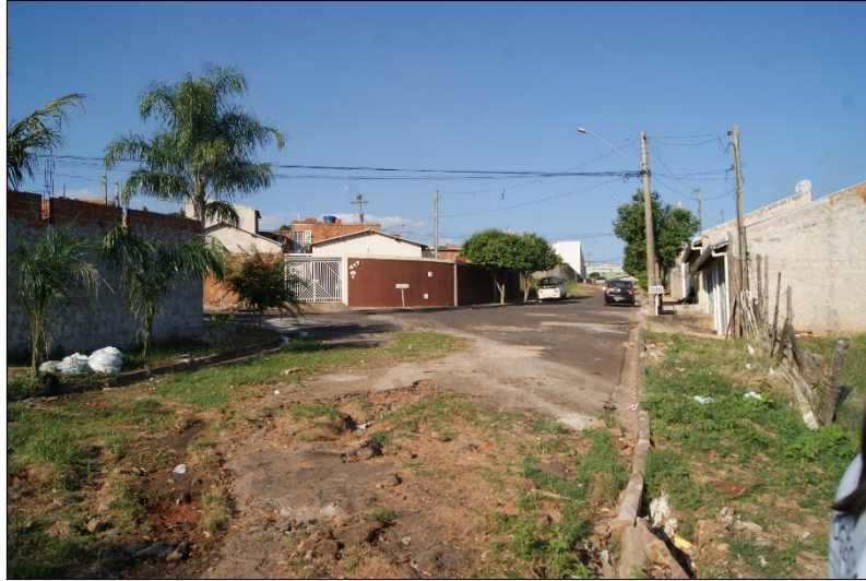
Figura 79 - Aspectos gerais do ponto 7, com destaque para o asfalto degradado.
