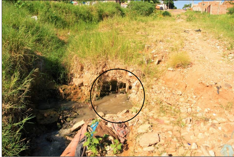
Figura 69 - Aspectos ponto 5, características do declive, do solo, da rocha exposta e destaque para cano vertendo esgoto.
