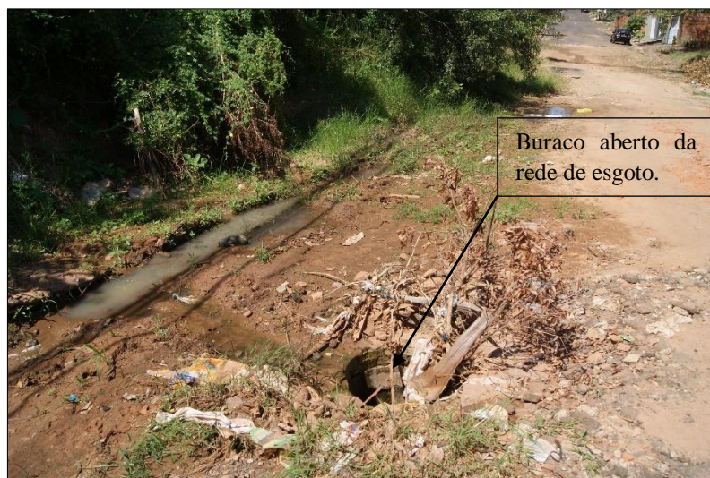
Figura 63 - Aspectos da cabeceira do córrego no ponto 4, destaque para diversidade de entulhos e presença de buraco da rede de esgoto (risco à população).
