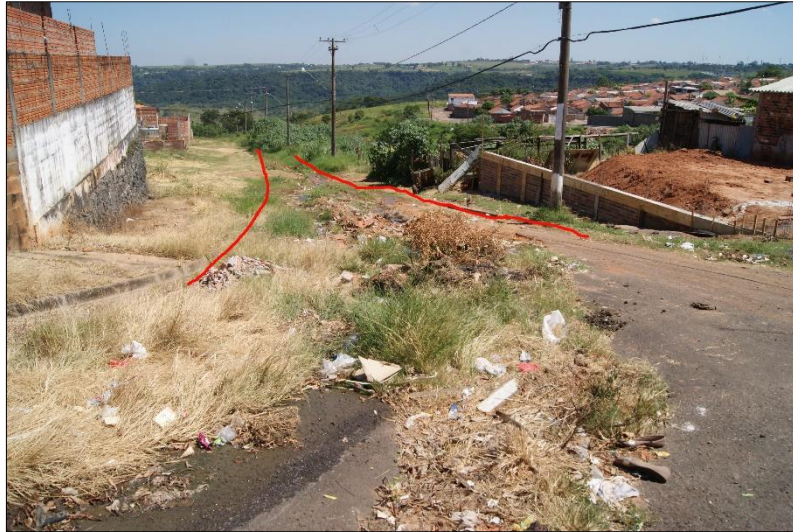
Figura 64 - Aspectos do sentido da rua, acompanhando o sentido da declividade no ponto 4 (favorece a concentração e escoamento superficial da água). Destaque também para os buracos no asfalto com entulhos.
