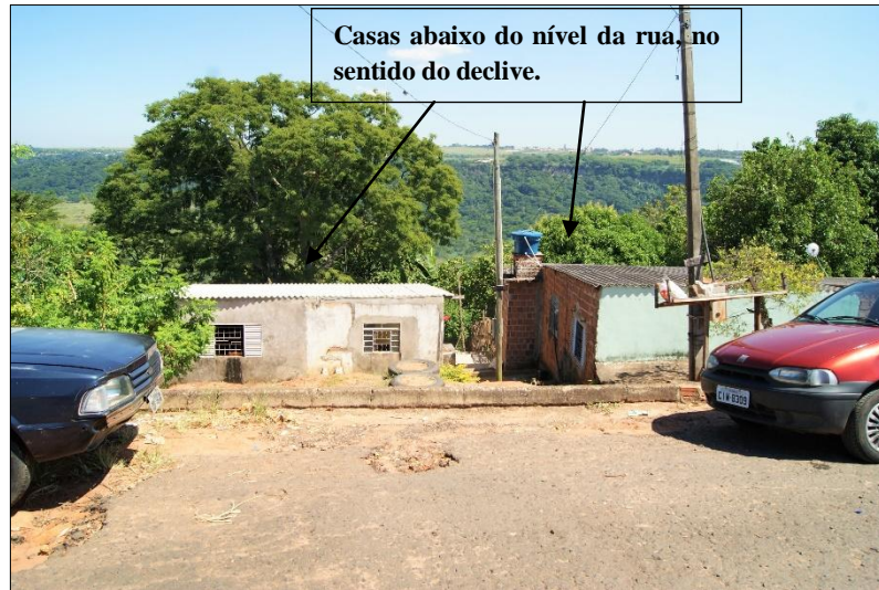
Figura 53 - Aspectos gerais do ponto 3, com destaque para as casas abaixo do nível da rua.
