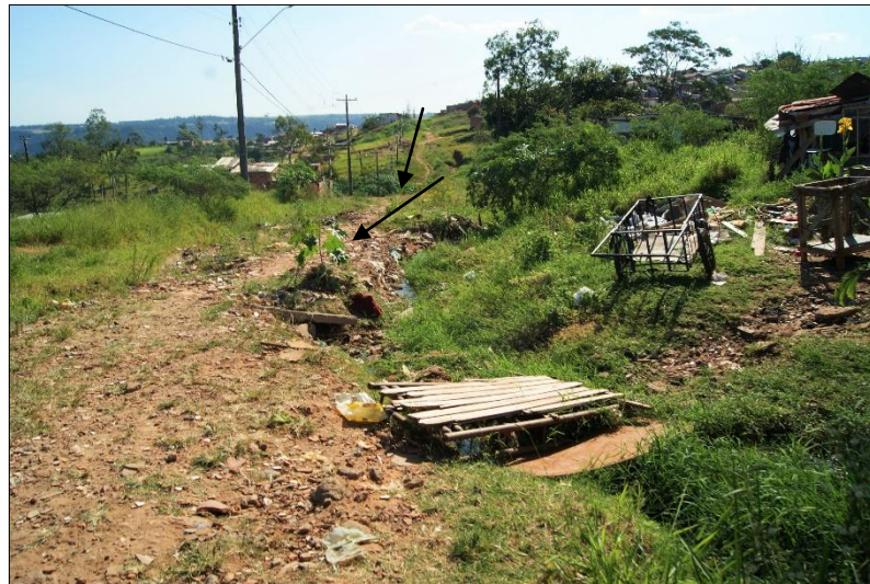
Figura 66 - Aspectos gerais do P5ZS, destaque para o arruamento no sentido do declive.
