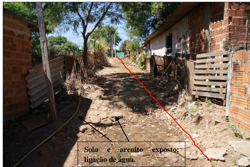
Figura 48 - Aspectos das moradias e da declividade no ponto 2 (linha vermelha), com destaque para exposição do solo, do arenito e ligação de água.
