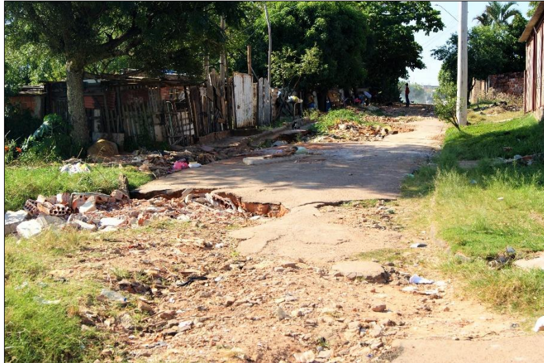
Figura 70 - Aspectos ponto 5, características das moradias e arruamentos (desgaste do asfalto). Observam-se crianças expostas aos lixos e entulhos.
