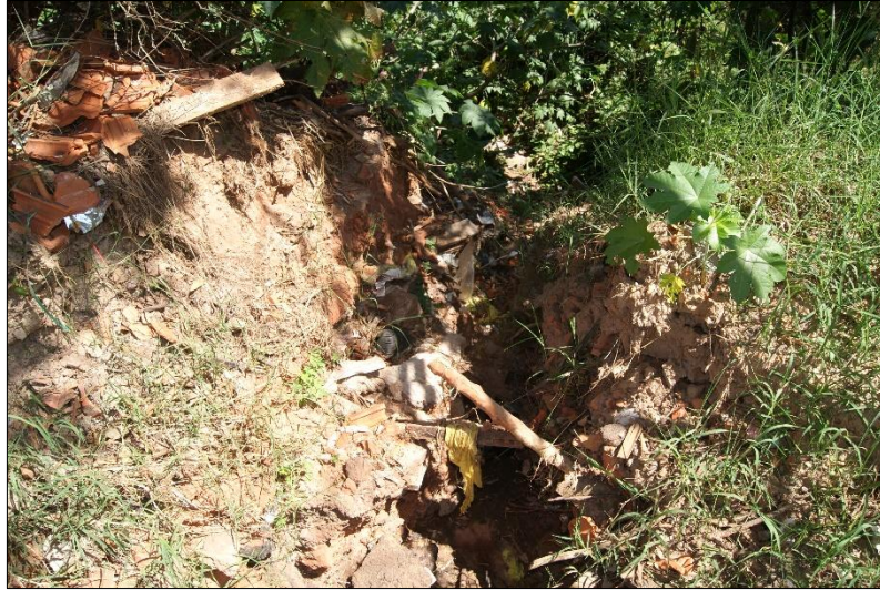
Figura 61 - Aspectos da cabeceira do córrego no ponto 4, destaque para erosão e entulhos.
