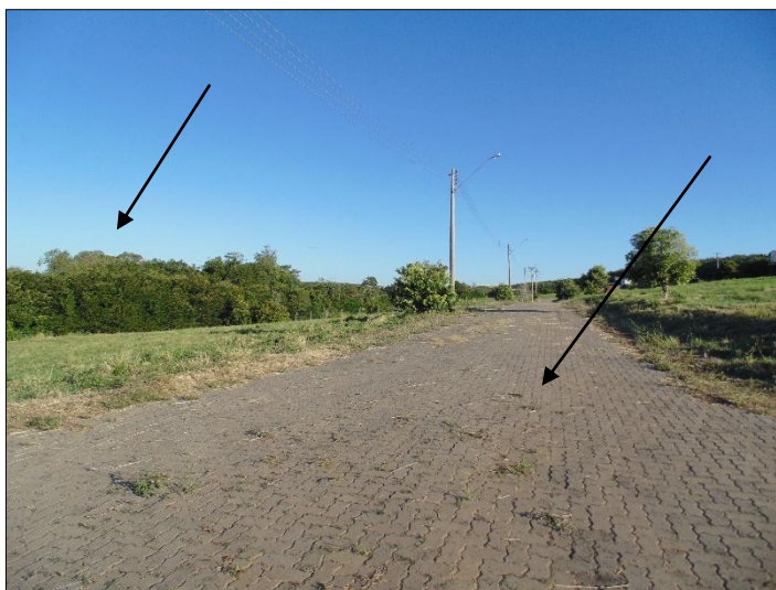
Figura 97 - Aspectos gerais do ponto 1, com destaque para o calçamento das ruas e cordão de vegetação isolando a área próxima à escarpa.
