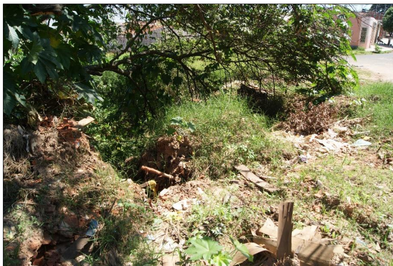
Figura 60 - Aspectos da cabeceira do córrego no ponto 4, erosão e entulhos.
