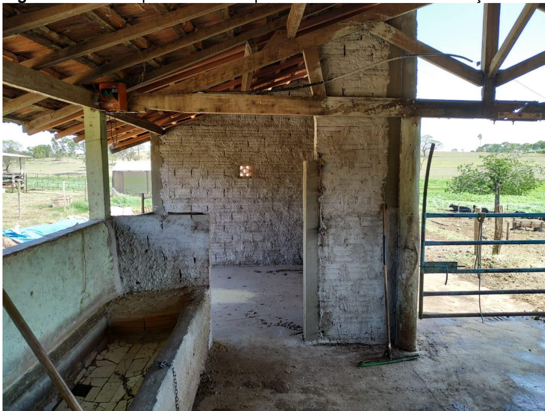
Figura 20 – Anexo para alocar tanque de resfriamento em construção
