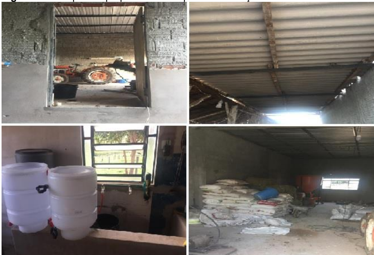
Figura 23 – Galpão da propriedade PD após a intervenção
