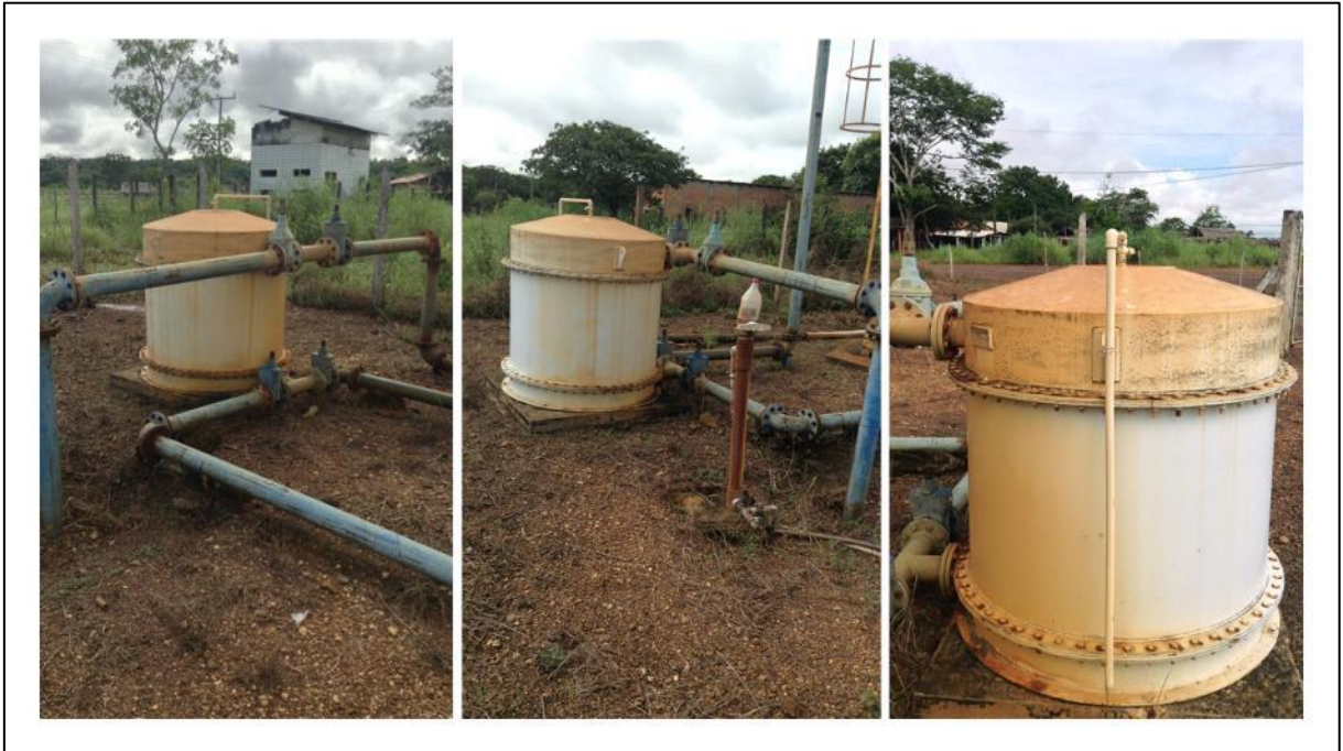
Figura 14 – Estrutura de tratamento da água observada no reservatório C2
