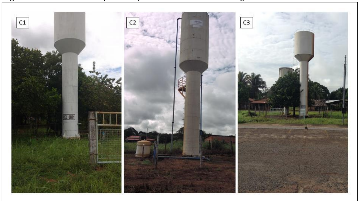
Figura 13 – Reservatórios públicos para o armazenamento de água da comunidade
