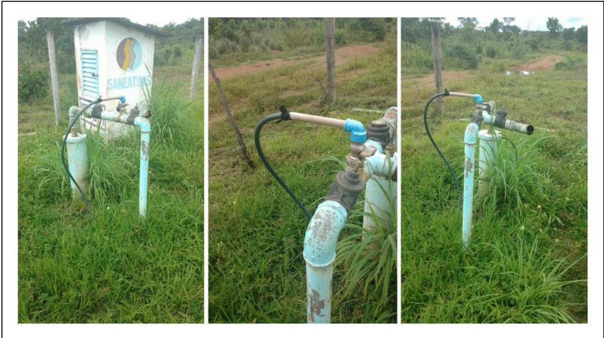
Figura 18 - Emenda no sistema de captação de água do ponto P1
