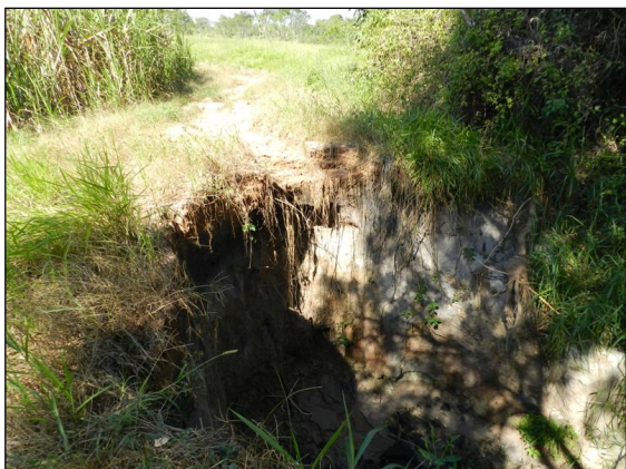
Foto 23: Voçoroca às margens da APP. Fonte: A Autora (05/05/2016).
