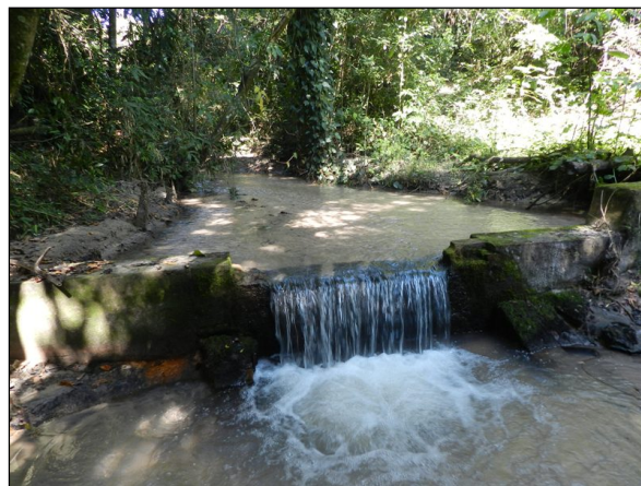
Foto 28: Pequeno barramento comprometido. Fonte: A Autora (05/05/2016).
