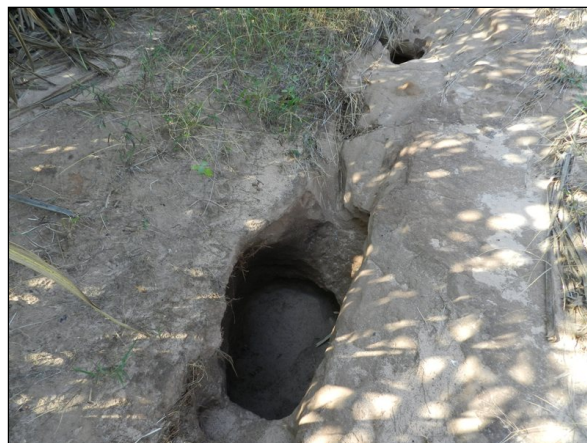
Foto 08: Sinais de perda de solo por erosão linear. Fonte: A Autora (05/05/2016).
