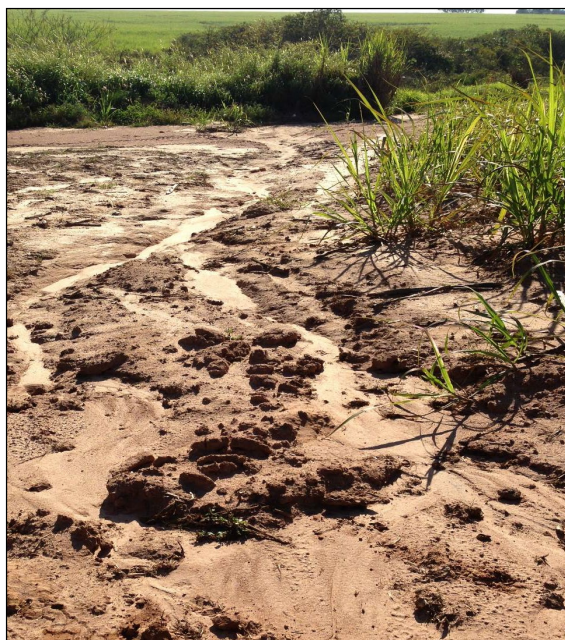
Foto 01: Processos erosivos próximos à nascente (2013). Fonte: O proprietário (2013).
