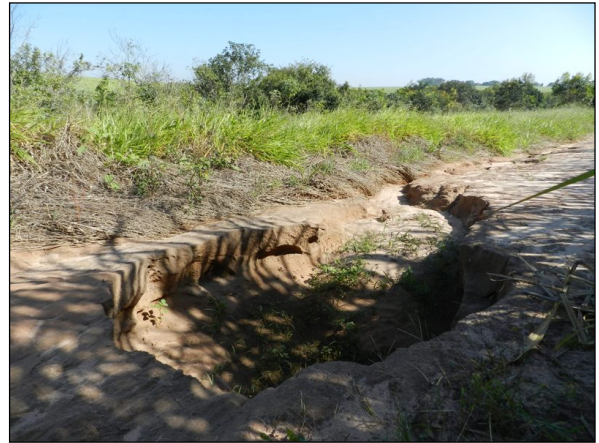
Foto 14: Erosão em Ravina. Fonte: A Autora (05/05/2016).
