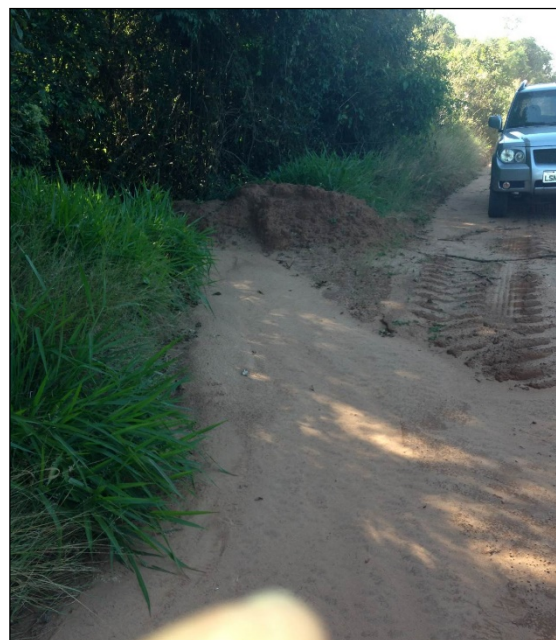
Foto 02: Chegada de sedimentos na APP (2013). Fonte: O proprietário (2013).
