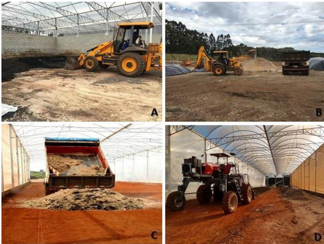
Figura 2 - A: Local de armazenagem do lodo, B:carregamento do caminhão basculante, C: Montagem das leiras, D: Vista da estufa e das leiras.
