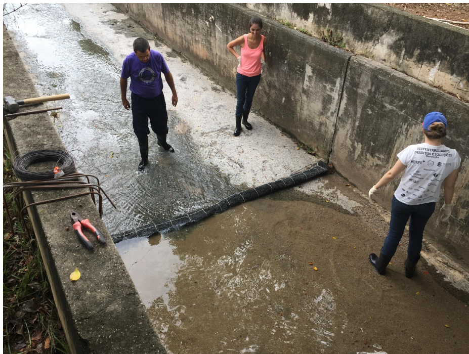
Figura 37 - Detalhe das intervenções do tipo “salsicha” no córrego 3 (R3).
