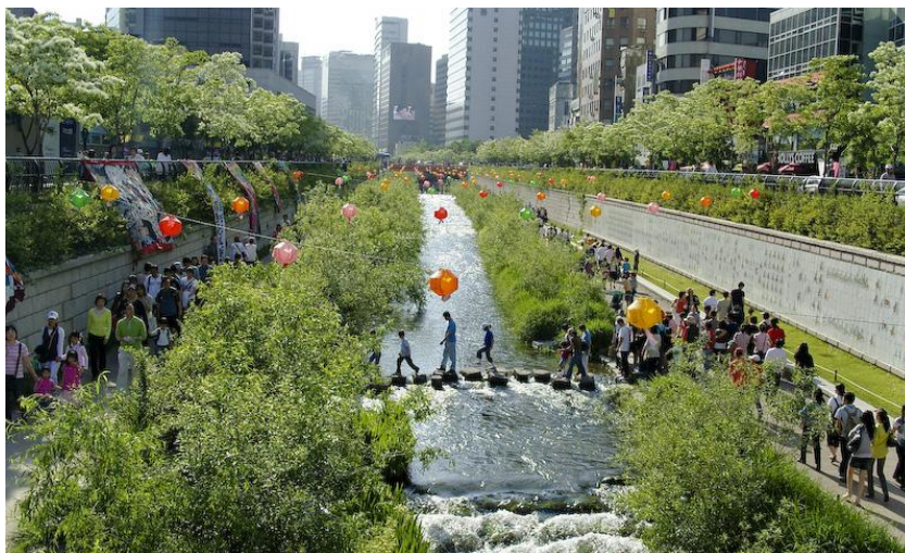
Figura 5 - Obras de revitalização do rio Cheonggyecheon concluídas.
