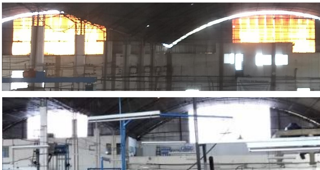
Figura 26 – Iluminação natural no galpão da empresa
