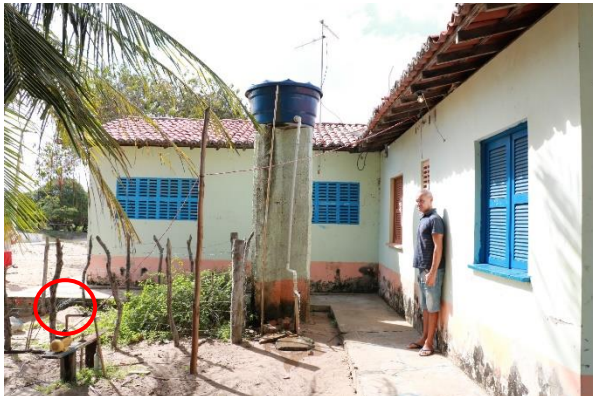
Foto 5 - Sistema de água que abastece a escola - Comunidade de Passarinho
