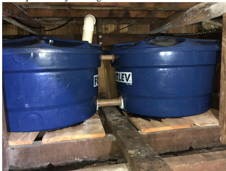
Foto 25 - Tanques de dejetos e águas servidas instalados nas embarcações
