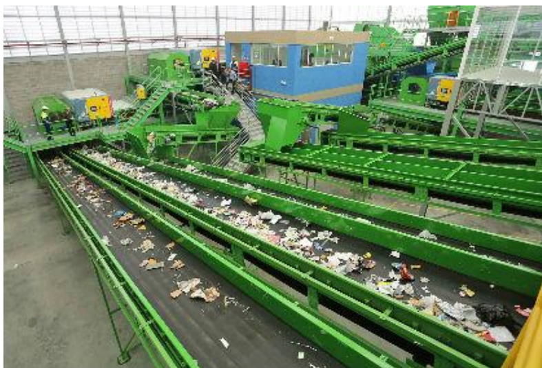
Figura 31 – 2ª. Central mecanizada de triagem de material reciclável – Cidade de São Paulo (Brasil)
