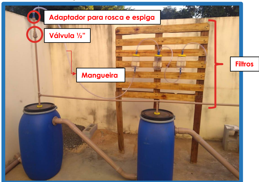
Figura 8 – Controle da saída de gás das bombonas para os filtros /Próprio Autor
