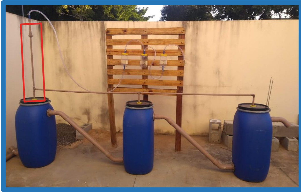
Figura 7 - Encanamento que ficará exposto/Próprio Autor
