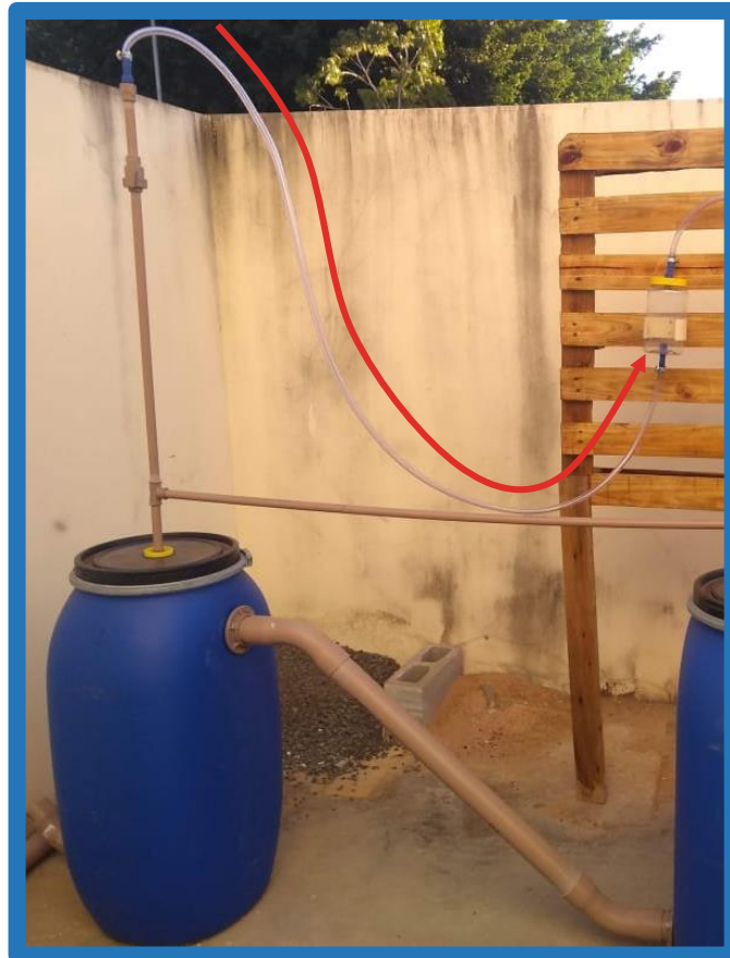
Figura 14 - Mangueira de entrada nos filtros/Próprio
