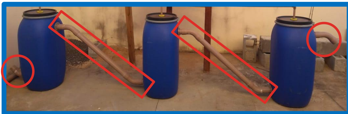
Figura 4 - Posição das conexões e encanamentos/Próprio Autor
