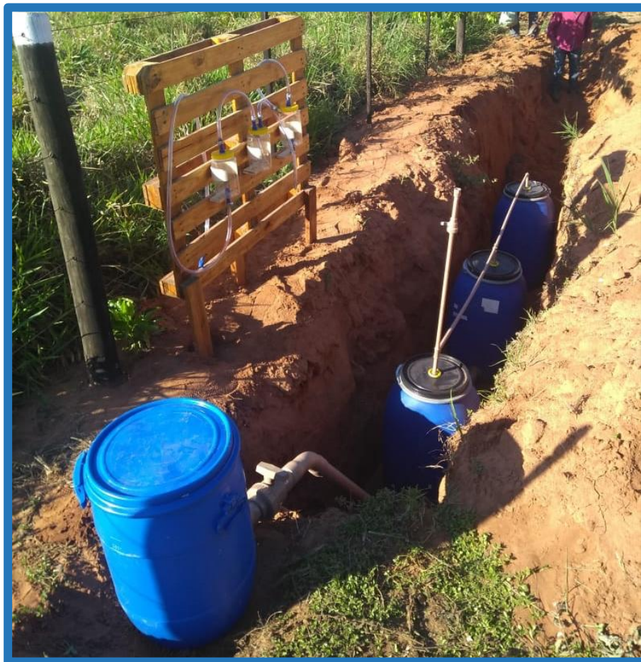
Figura 1 - Biodigestor sendo montado/Próprio Autor
