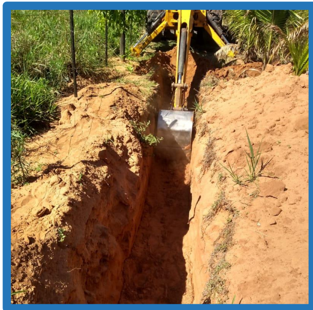
Figura 20 - Local de instalação do equipamento/Próprio Autor
