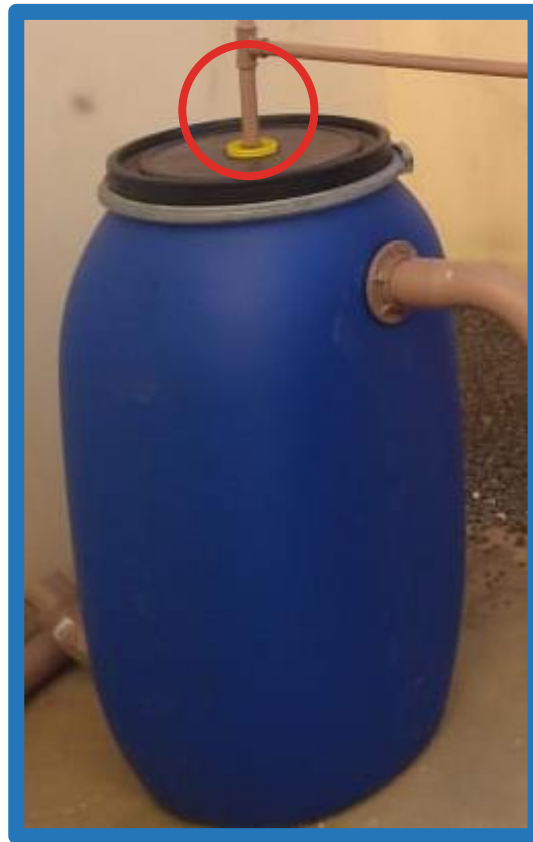
Figura 5 - Peça de Cano na saída da tampa da bombona/Próprio Autor
