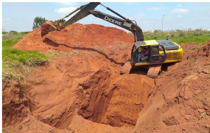
Figura 33. Escavação de trincheira de 9,0 metros de profundidade
