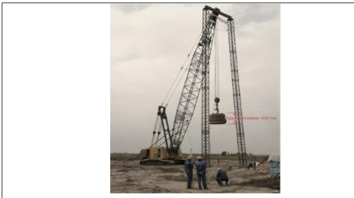
Figura 19. Equipamento de Compactação Dinâmica
