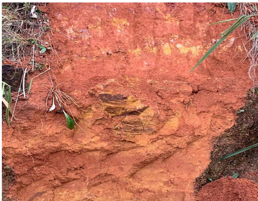
Figura 22. Aspectos estruturais da base da cobertura correlata à Fm. Rio Claro (Rod. Luís de Queiróz km 159)
