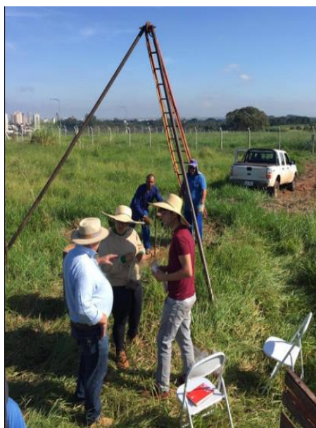
Figura 35. Execução de sondagem a percussão ao lado da escavação.
