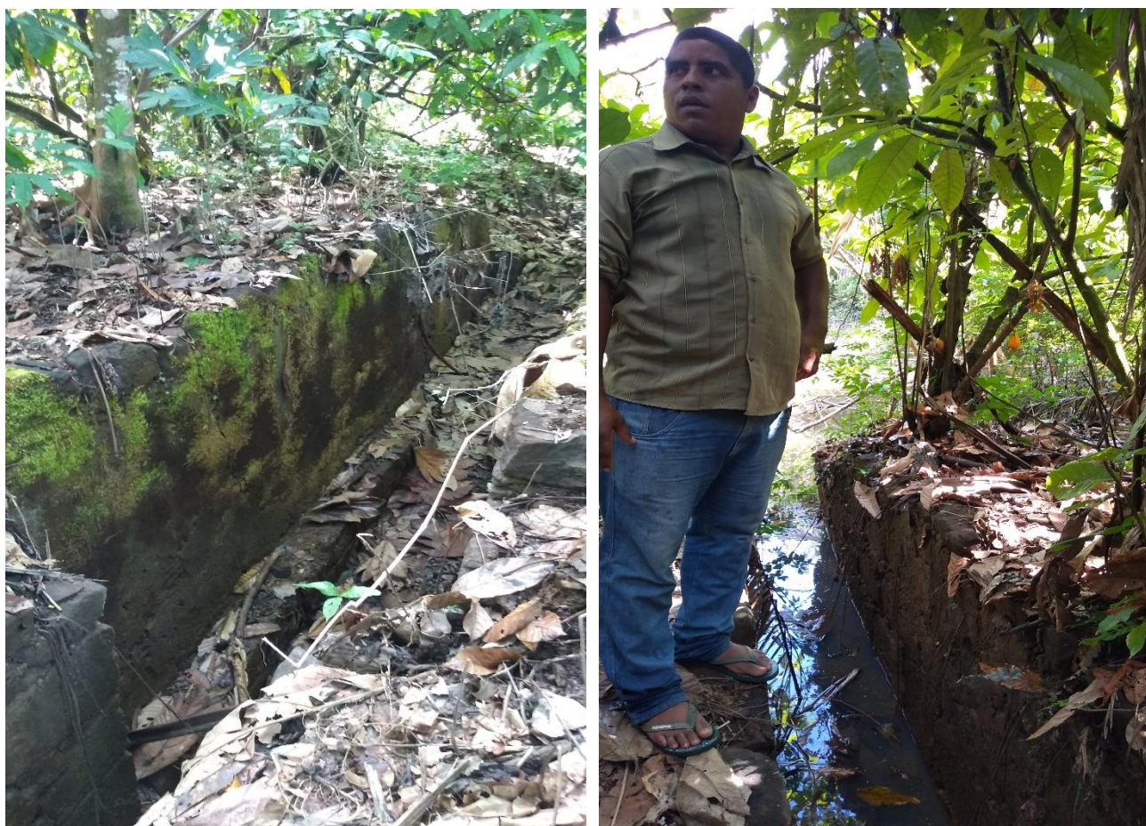
Figuras 33 e 34: Canal de escoamento de água do engenho na fazenda Turé.
