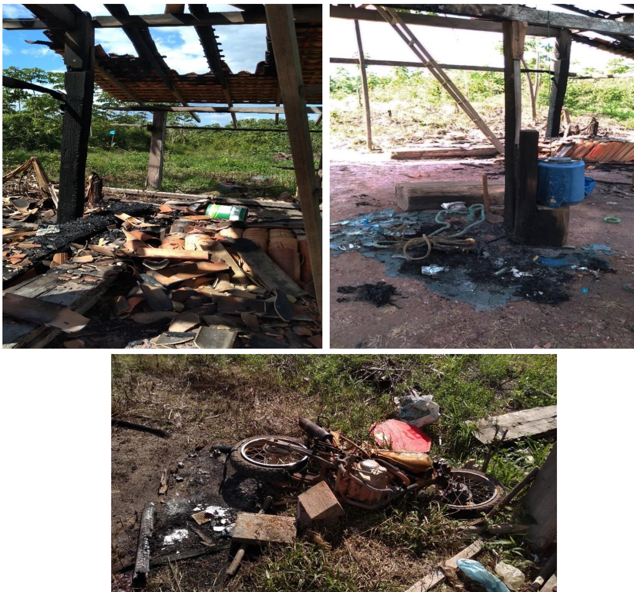
Figuras 28, 29 e 30: Casa de morador quilombola que foi invadida e queimada.
